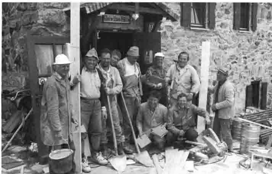
Trotz schwerer Arbeit gut gelaunt! Viel zu tun gab's für die Tittmoninger Stammtruppe bei der Sanierung des Erdgeschosses in den Jahren 1984/85
