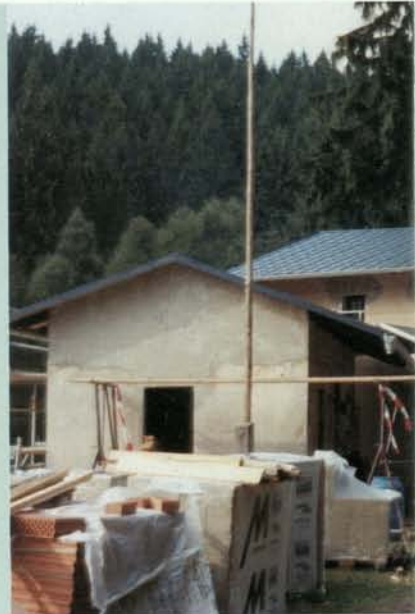
2001: Die Sanierung läuft auf Hochtouren.
