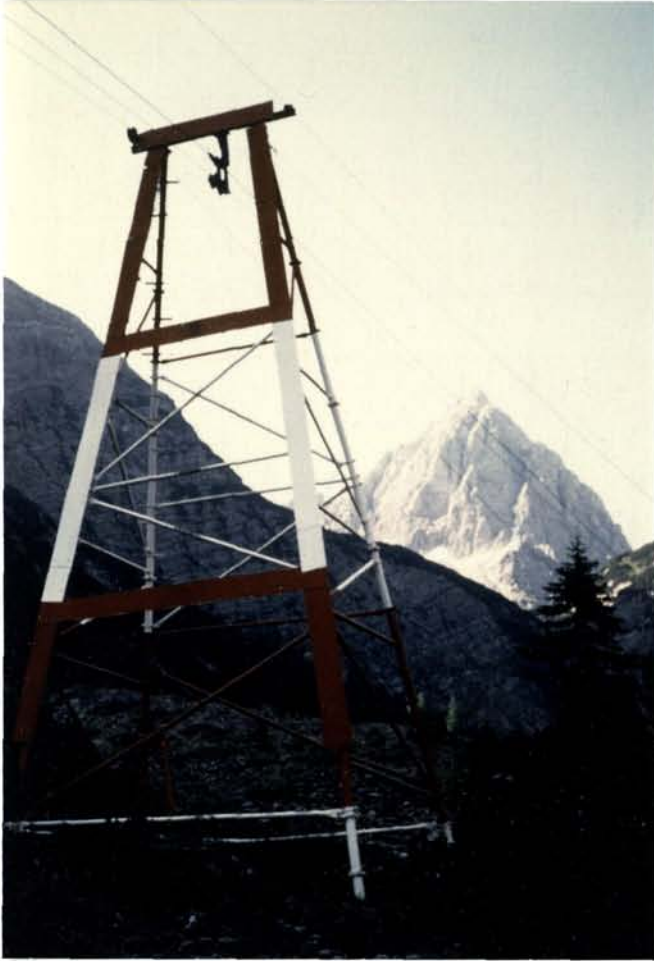
Der untere Mast der Materialseilbahn mit Dremel
