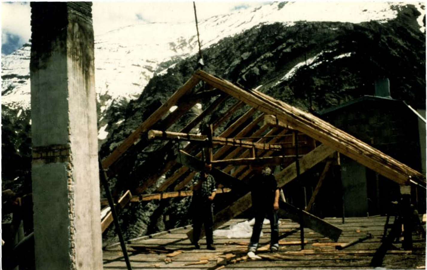
Die Reste des Daches vom Holzhaus der Hanauer Hütte, werden abgetragen
