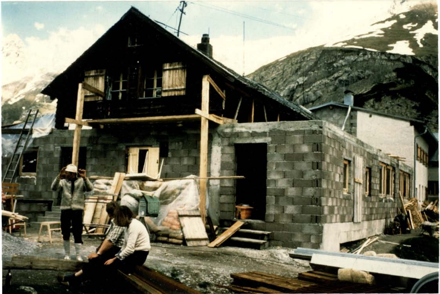
Das Holzhaus der Hanauer Hütte, sowie die Veranda wird ummauert und dem Zwischenbau angeglichen
