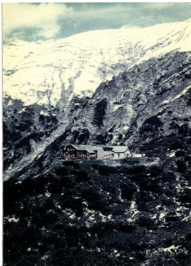
Der Zwischenbau der Hanauer Hütte ist im Rohbau fertig
