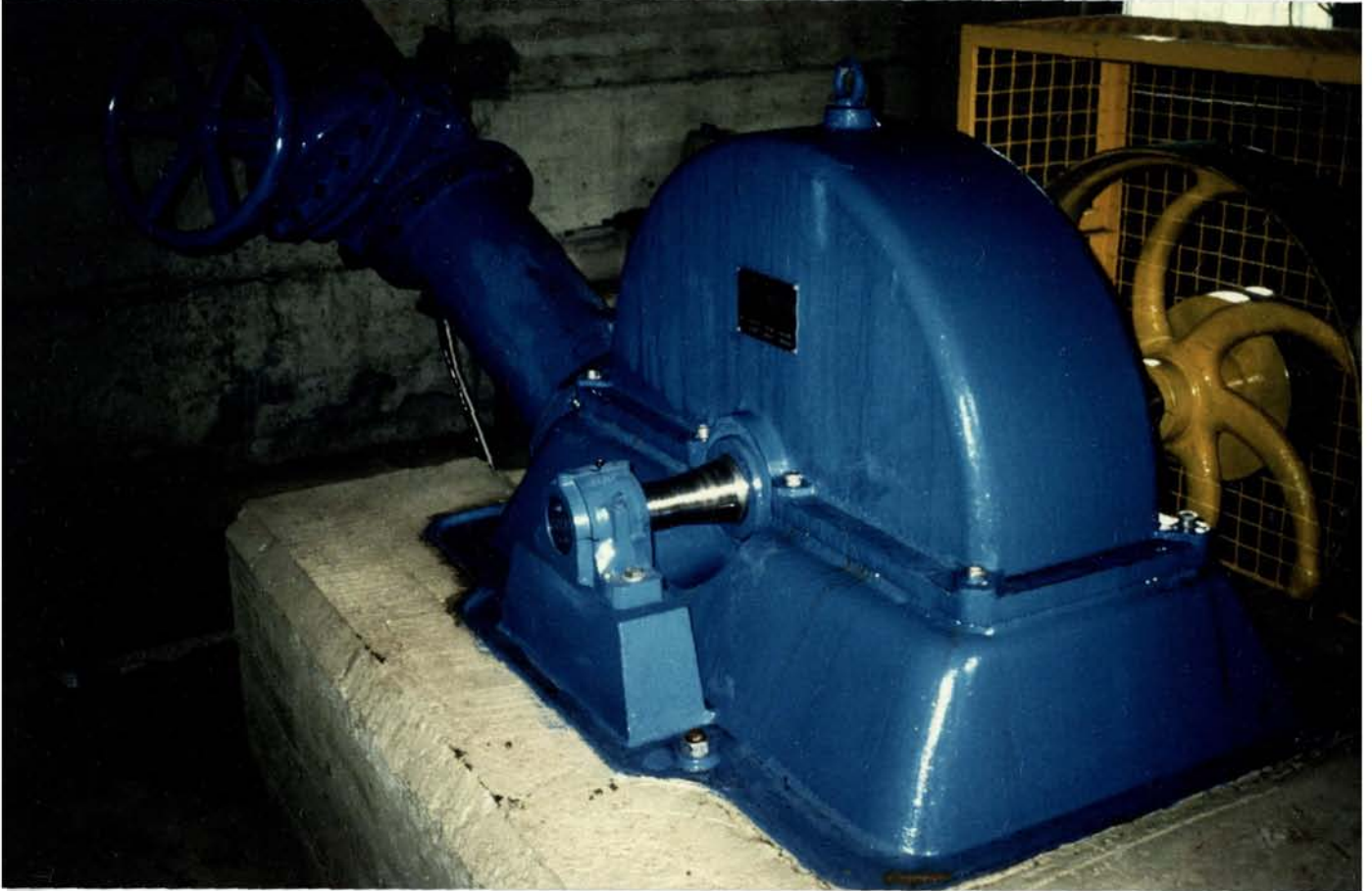
Pelton turbine, eindüsig. Fabr.: Fa. Geppert, Baujahr 1991, QA = 150 l/s, nT = 330 min -1 , NT = 48,0 kW
