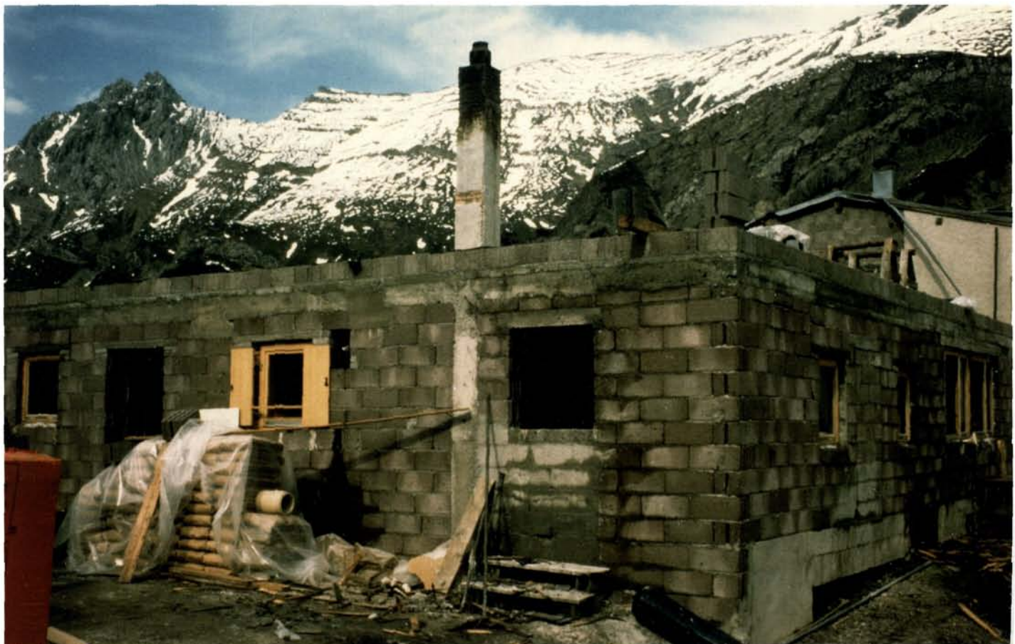
Das alte Holzhaus ist ummauert, die Decke über dem Erdgeschoß betoniert
