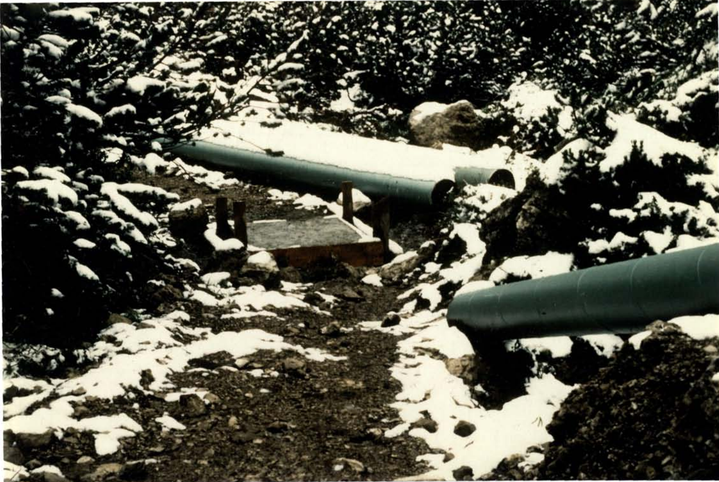
Ein Jahr ruht die Arbeit an der Druckrohrleitung und dem Kleinwasserkraftwerk, ehe es fertiggestellt wird
