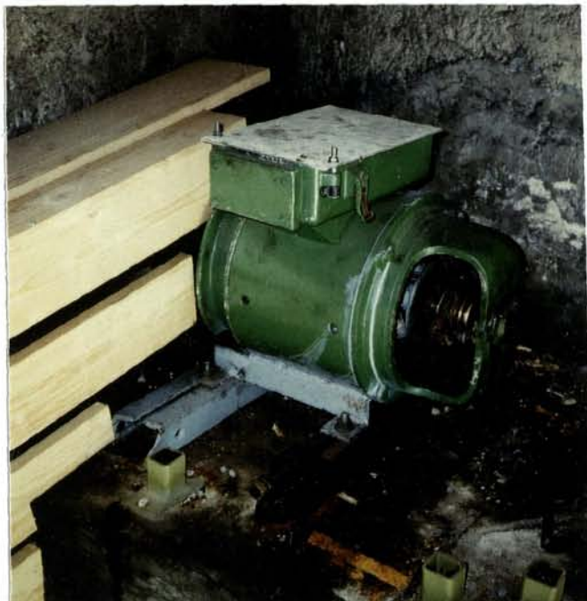
Die Dynamomaschine leistet 25 Ampere bei 220 Volt, rund 5,5 PS bei 1120 U/min
