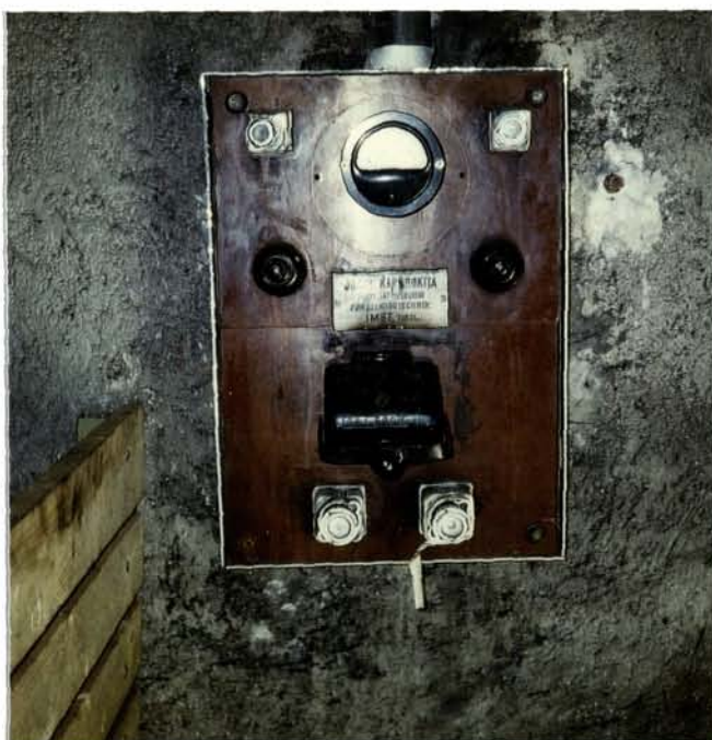
Die Wandschalttafel mit Hauptschalter.
