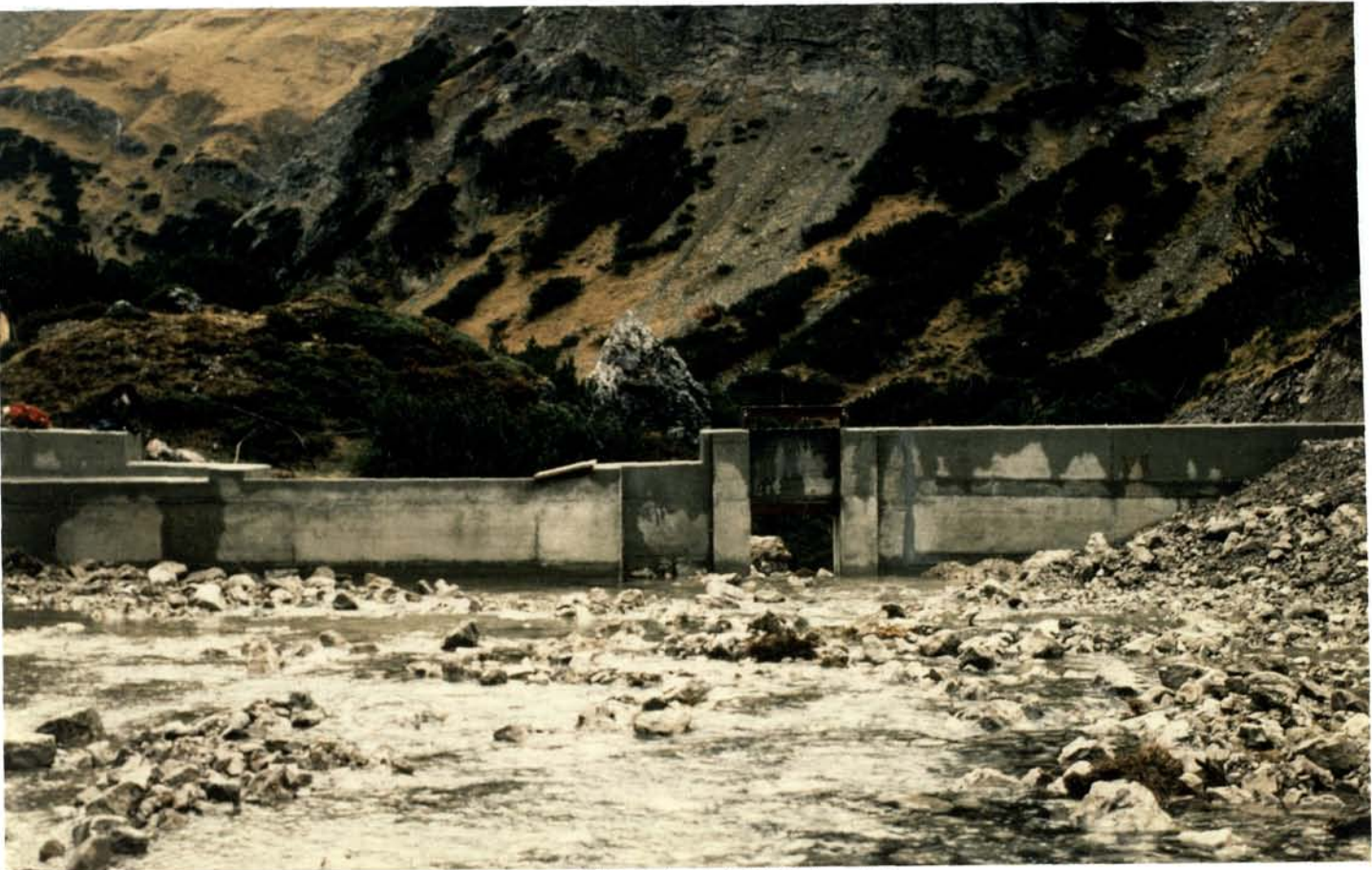
Staumauer und Entsander sind 1987 fertiggestellt
