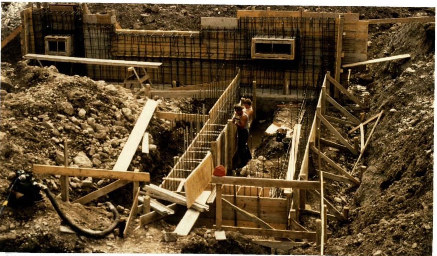
Einlaufwerk im Bau, der Untergrund war kein Fels sondern nur Schotter
