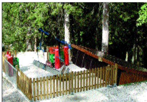
Die neu errichtete Talstation im Oktober 2001
