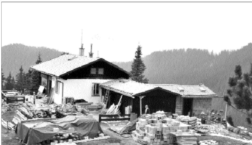
Die Großbaustelle Hochlandhütte im Jahr 1985
