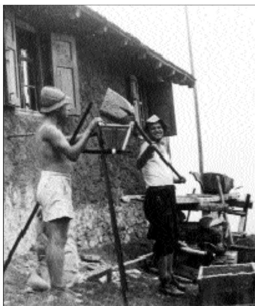
Bauarbeiten auf der Hochlandhütte
