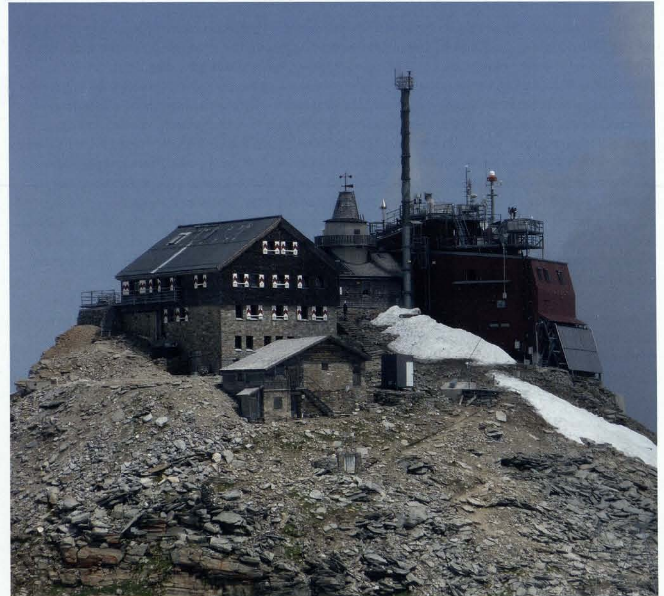
Das Zittelhaus mit Wetterstation heute
