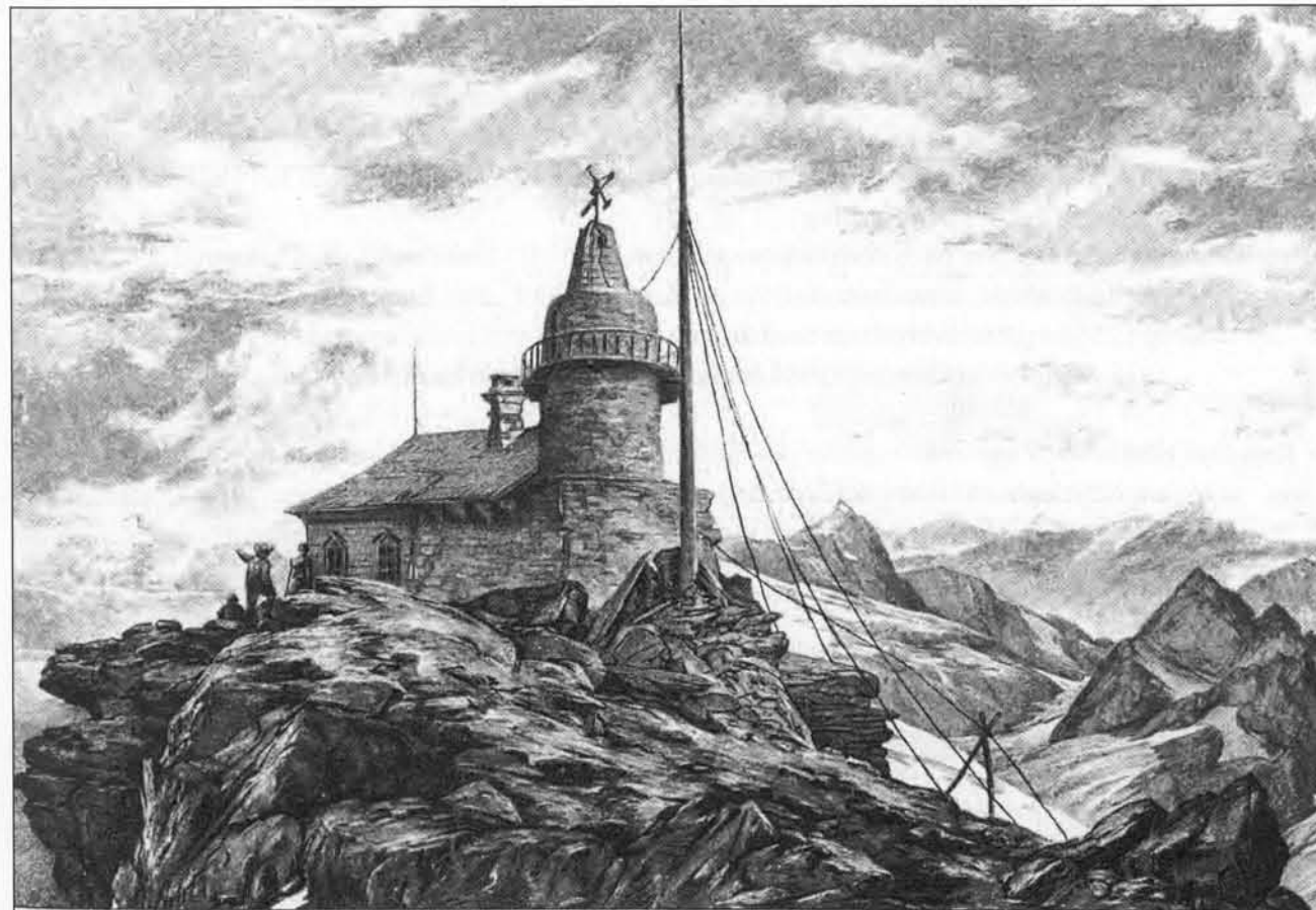
Das Sonnblickobservatorium nach seiner Erbauung im Jahre 1886 nach einem Stich von Heilmann
