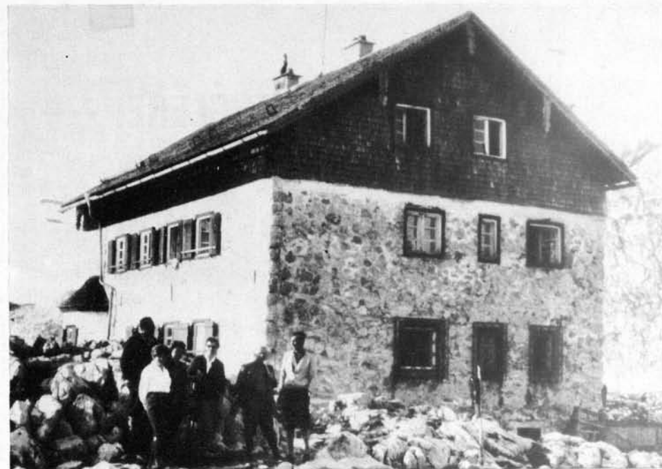
Eine frühe Aufnahme des Ingolstädter Hauses auf der Diesbachscharte. Es ist bis heute in seiner geschlossenen ursprünglichen Form erhalten geblieben.
