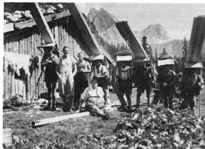
Lastentransport von der Kallbrunnalm zur Diesbachscharte im Sommer 1927 beim Bau des Ingolstädter Hauses (Vom sitzend: 1. Vorstand Justizrat Eixenberger)
