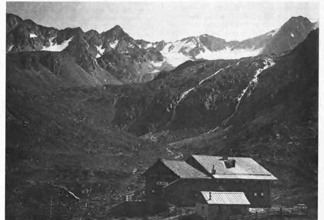
▼ Die Hütte nach dem Ausbau 1932/33
