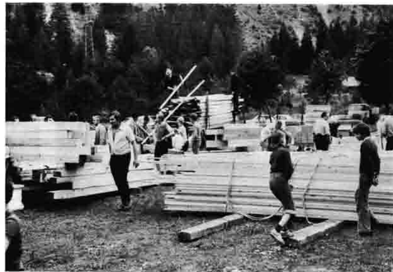
Baumaterial liegt für den Hubschrauber bereit
