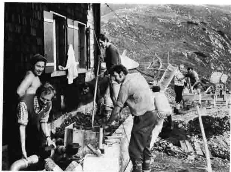
Fundament und Wasseranschluß werden errichtet
