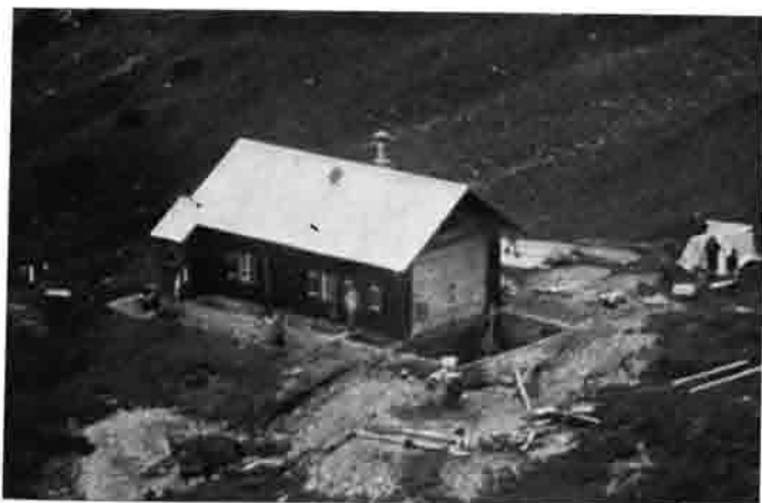
Der ausgeschachtete Keller
