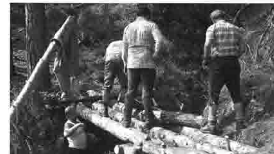
Weginstandsetzung zur Hütte
