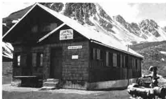
Die Hütte nach dem Anbau
