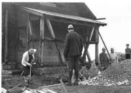
Spender kauften fleißig Bausteine für den Anbau
