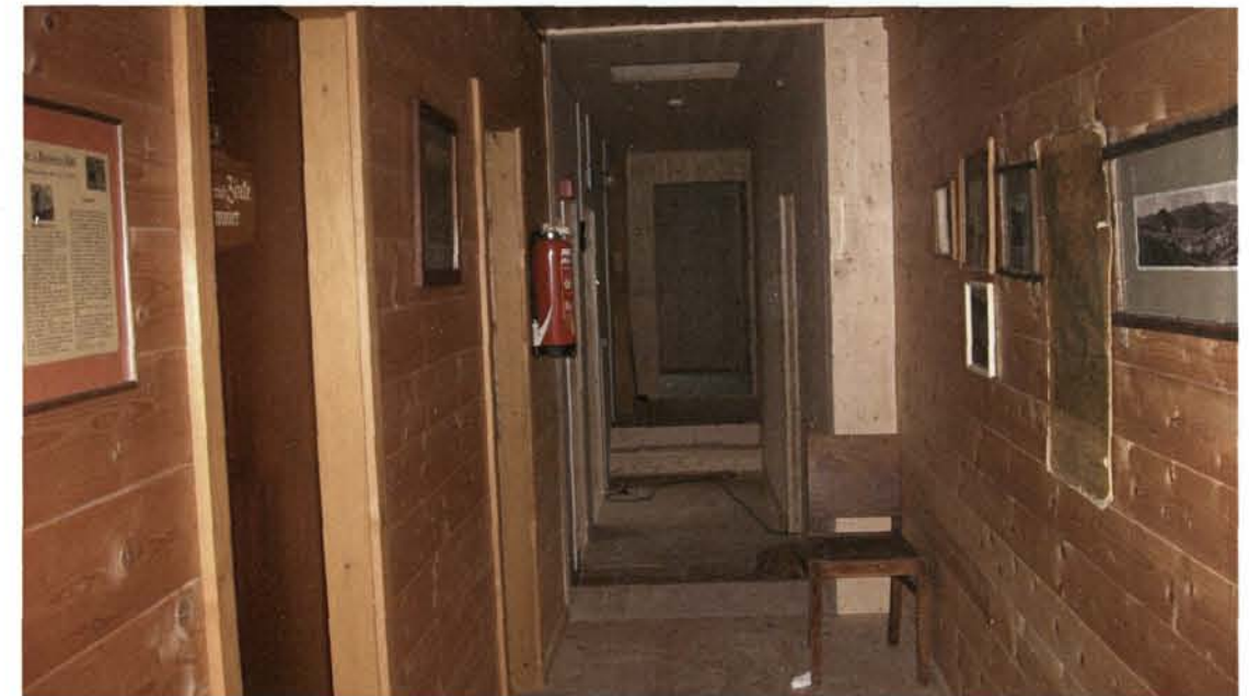
Übergang zwischen Alt- und Neubau
