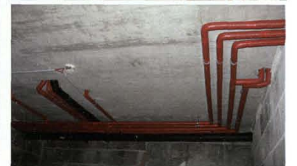
Viele neue Rohre mussten verlegt werden
