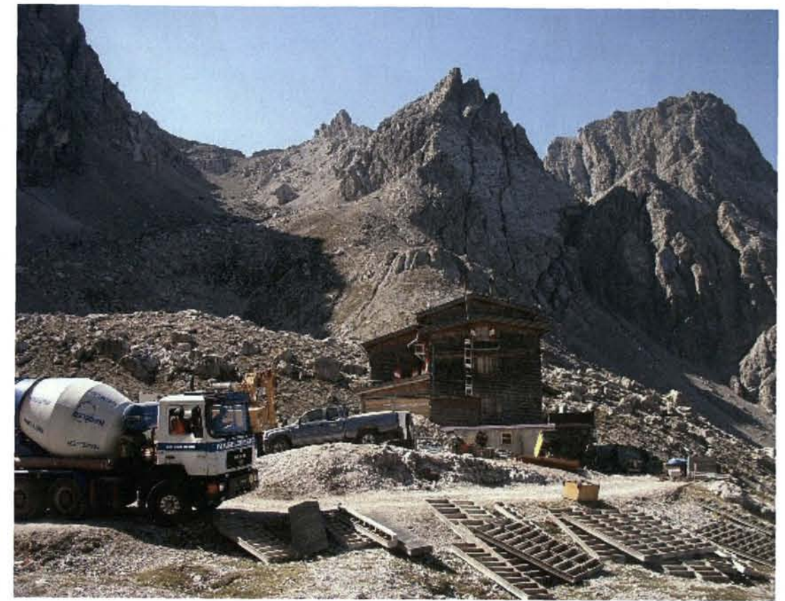
Auch ein Betonmischer war vor Ort im Einsatz
