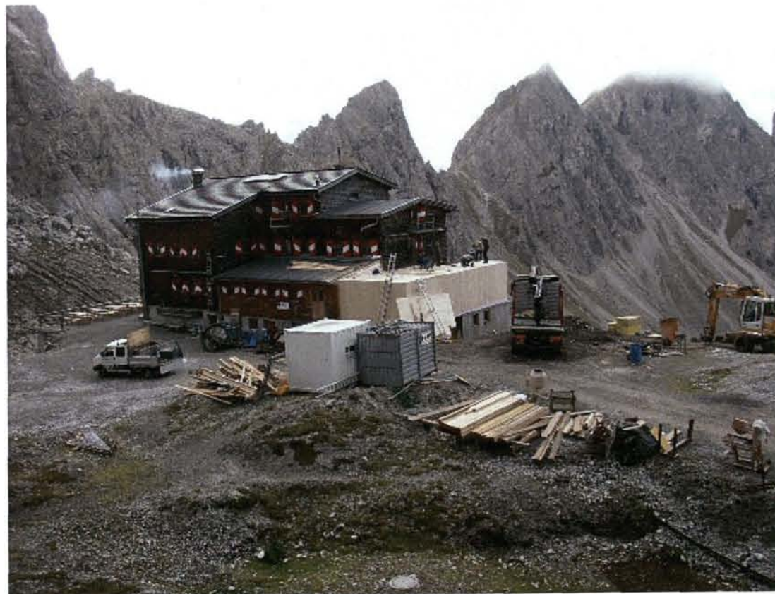
Das Erdgeschoss ist bereits fertig
