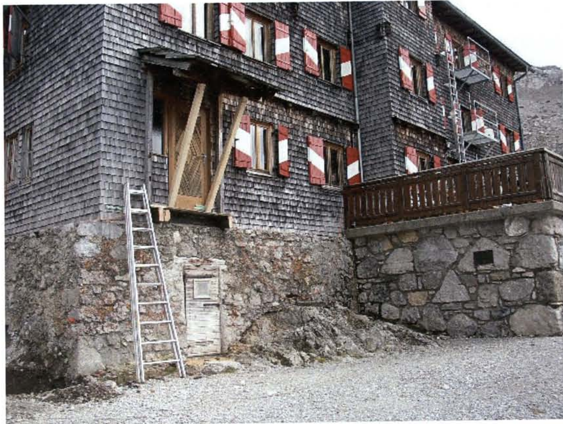
Hier entsteht die neue Terrassen - Erweiterung – mit weiterem Eingang
