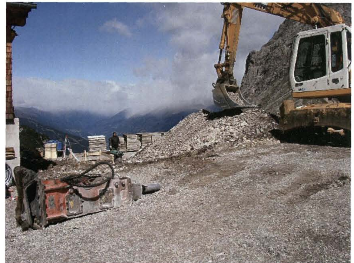
Sogar ein Bagger musste den steilen Weg zur Hütte überwinden
