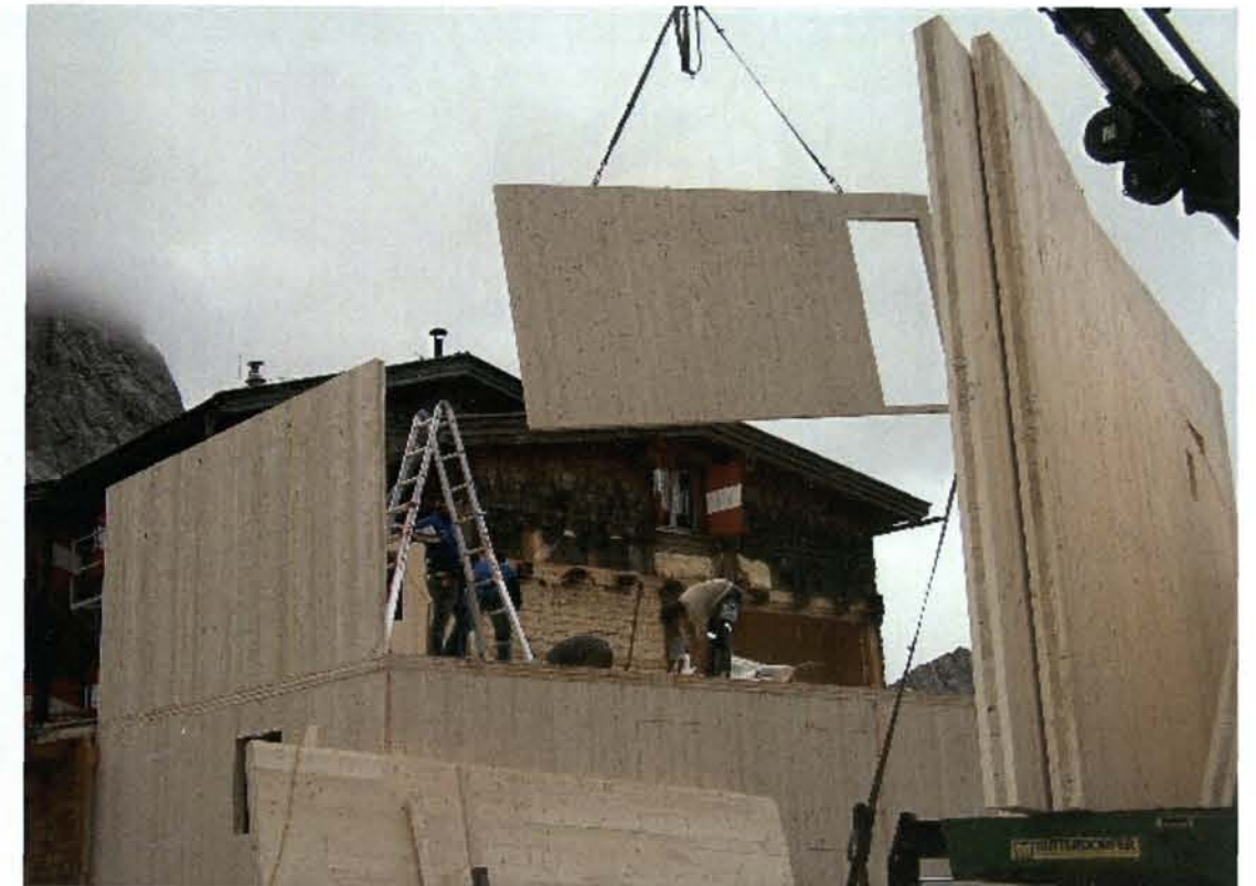
Die vorgefertigten Holzteile werden zusammengesetzt
