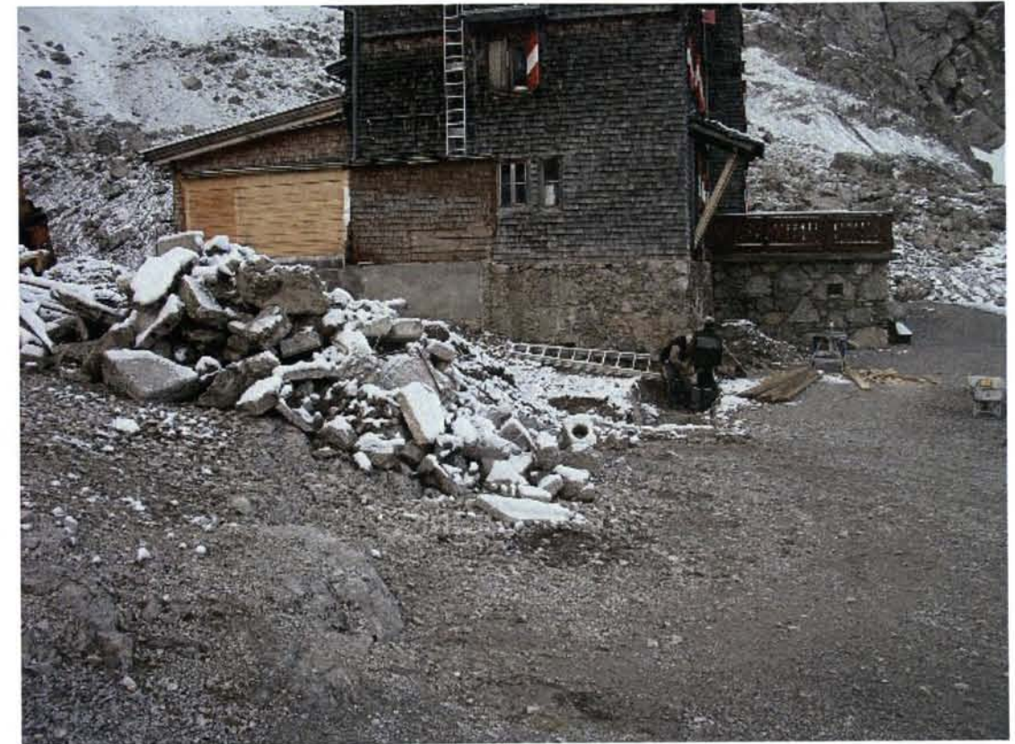
Auch Schneefall konnte die Arbeiten beim Anbau nicht aufhalten
