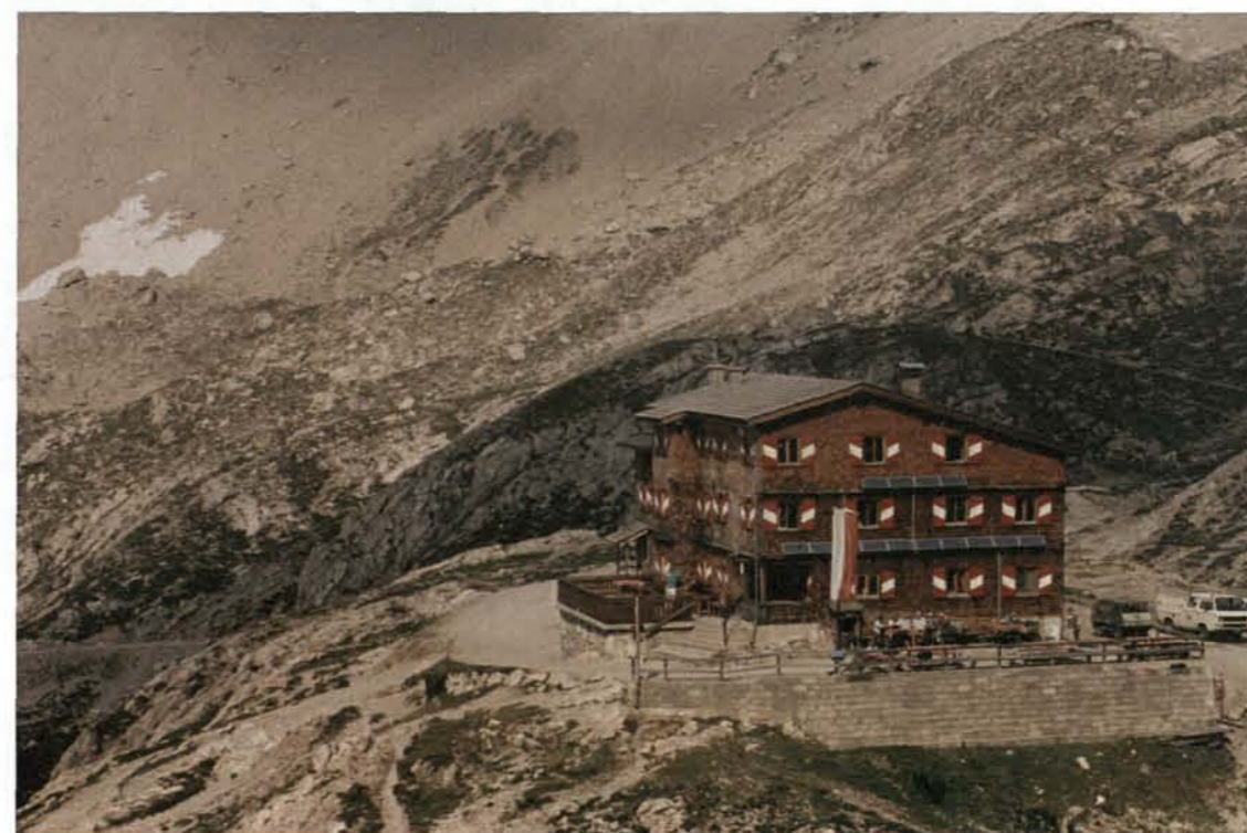
Hier sind die beiden neuen Terrassen sowie die weitere Aufstockung sichtbar.
