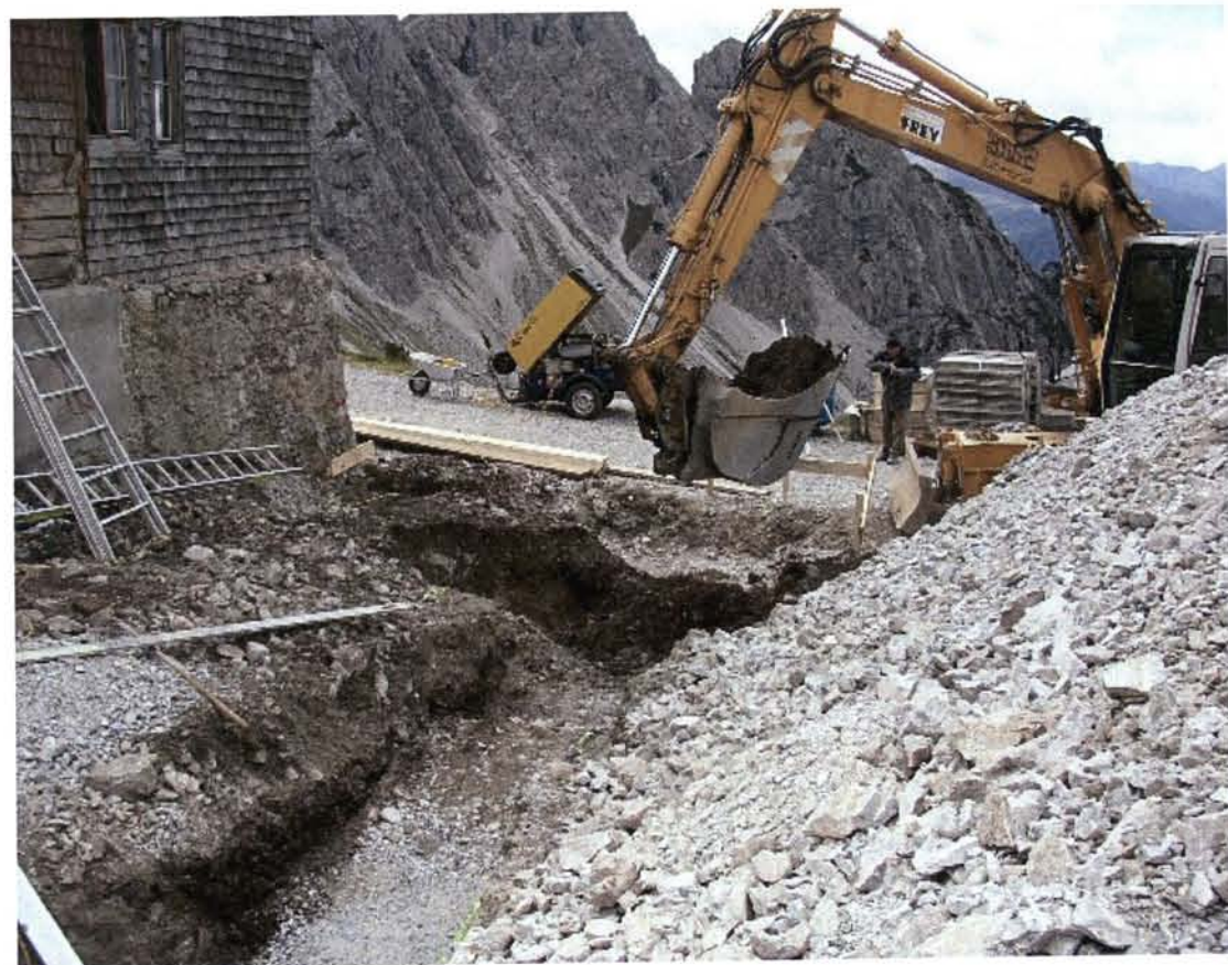
Ausgrabungsarbeiten für die Fundamente
