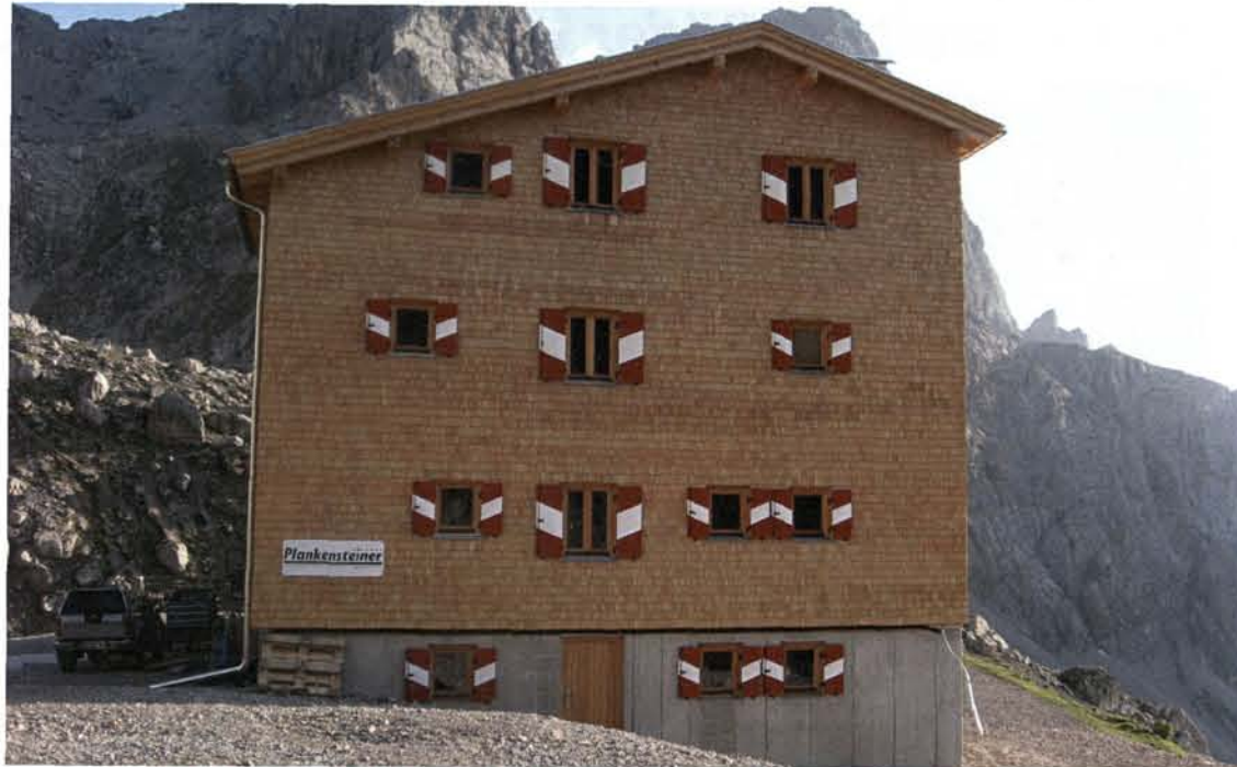
Beim Anbau sind wieder Holzschindeln angebracht worden.
