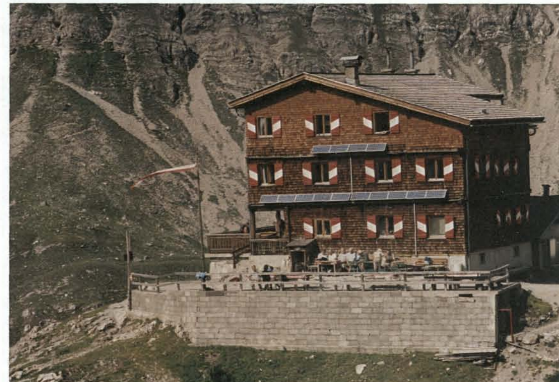
Seitenansicht gegen Saazer Weg mit der Solar-Anlage und neuen Süd-Terrasse
