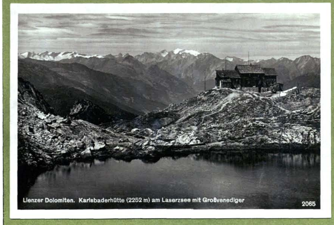
Nach dem II. Umbau
