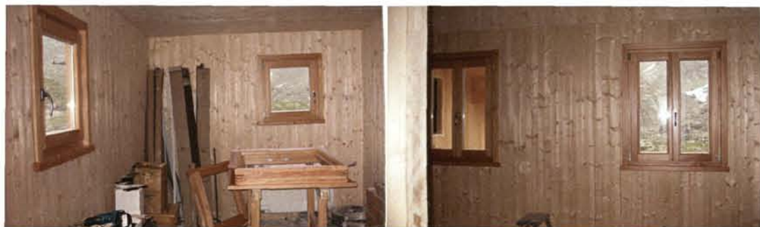
Die ersten Fenster sind gesetzt
