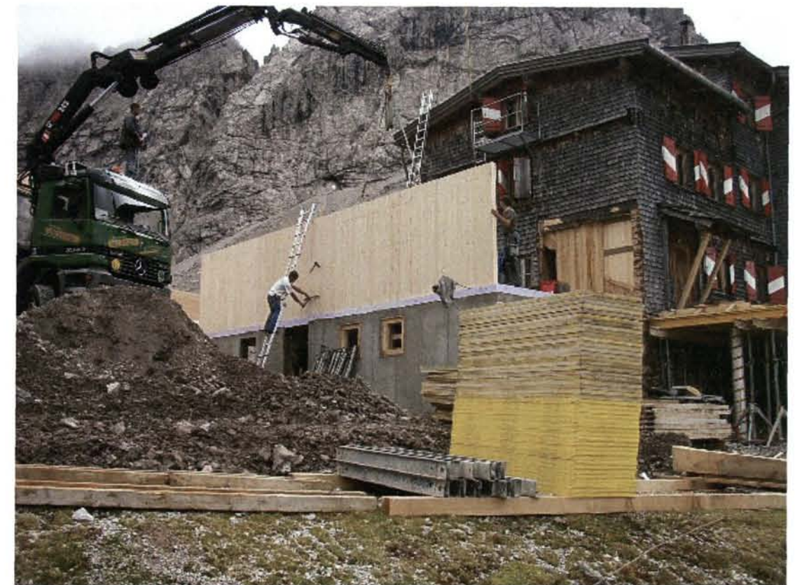
Die ersten Holzwände werden gesetzt
