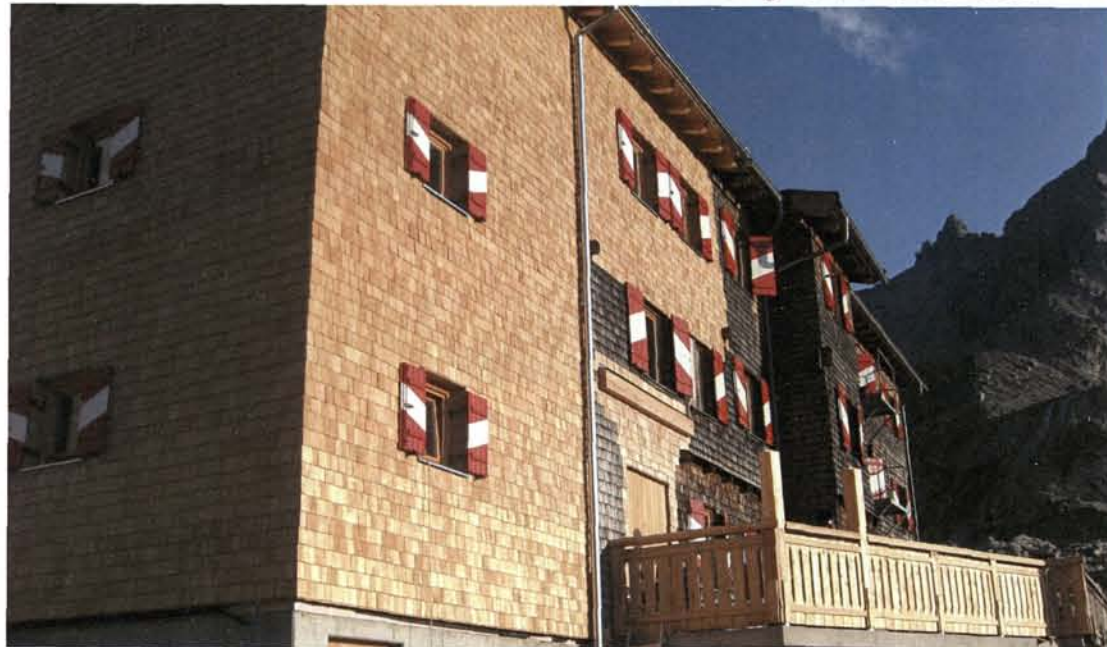
- mit der Terrassen-Erweiterung
