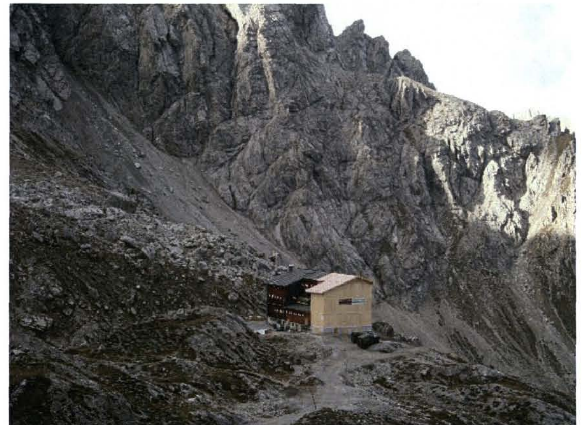
Der Anbau – Nord-Ost-Ansicht
