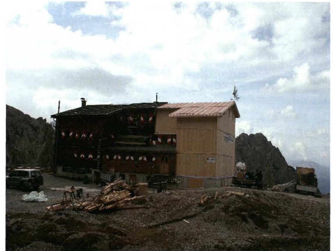
Nach der Hebfeier – der Anbau ist winterfest Aufatmen: Die wichtigsten Arbeiten sind erledigt - der Hebbaum ist gesetzt
