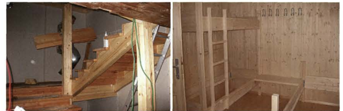
Treppen werden verlegt
