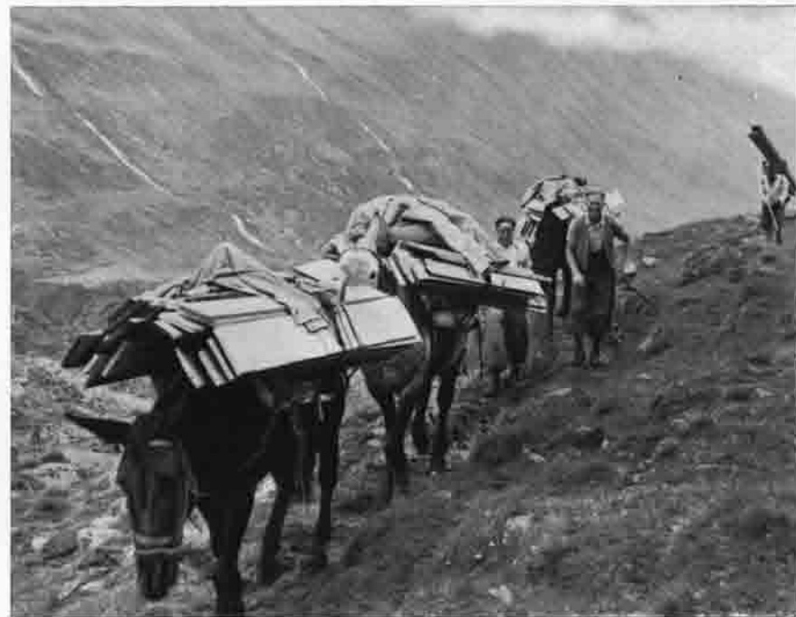
Transport-Schwierigkeiten. Für den Neubau mußten 120 000 kg mittels Geländewagen, Maultier und Drahtseilbahn auf 2883 m hinaufgeschafft werden. Bild 1: Ein Kasten wird über den Gletscher getragen. — Bild 2: Im Schnee eingebrochener Maultier. — Bild 3: Baumaterialienkarawane unterwegs. (Bild 1 und 2 Aufn.: Pohl, Bild 3 Aufn.: Stroffer)
