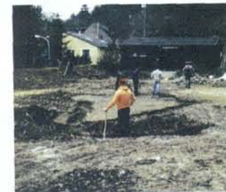
Erdarbeiten auf dem „neuen“ Sektionsgelände
