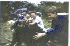
Aufbau der Teufelsley-Hütte, 1969
