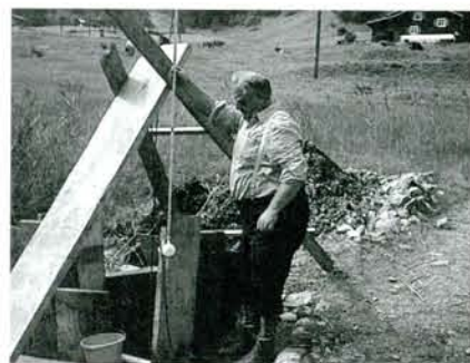
Bau der Kläranlage
