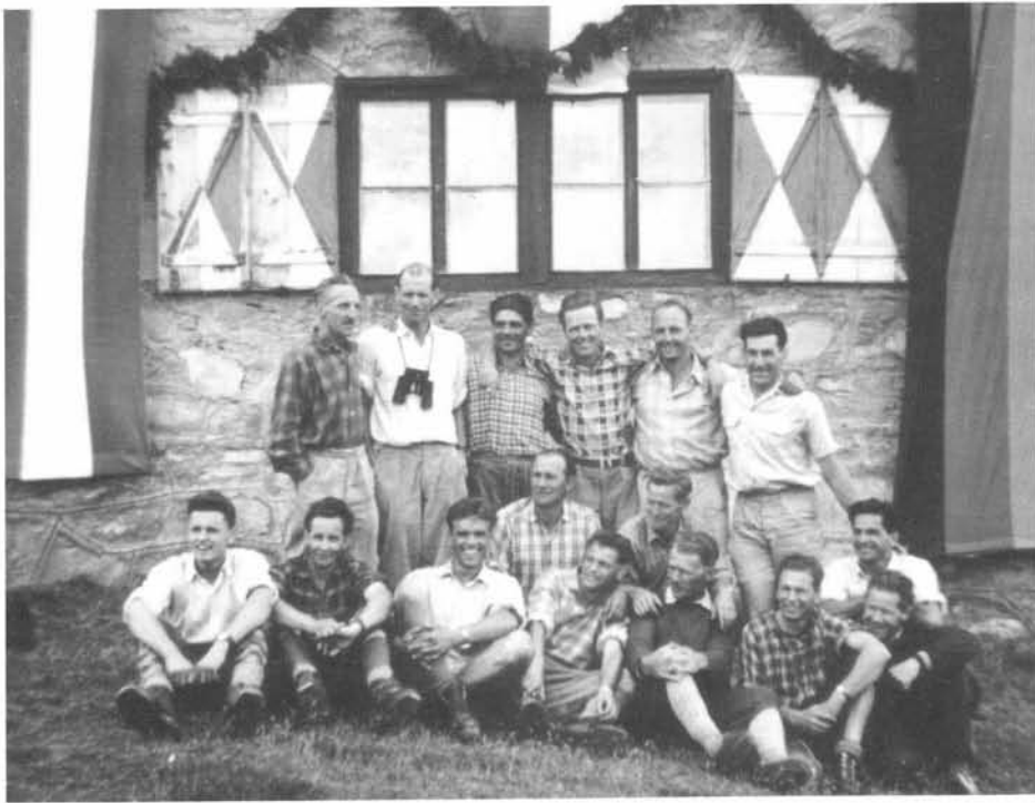
Die Belegschaft der Tauernkraftwerke errichten 1958 das Gipfelkreuz auf dem Kitzsteinhorn und machen nach den anstrengenden Arbeiten Rast vor der »Krefelder Hütte«
