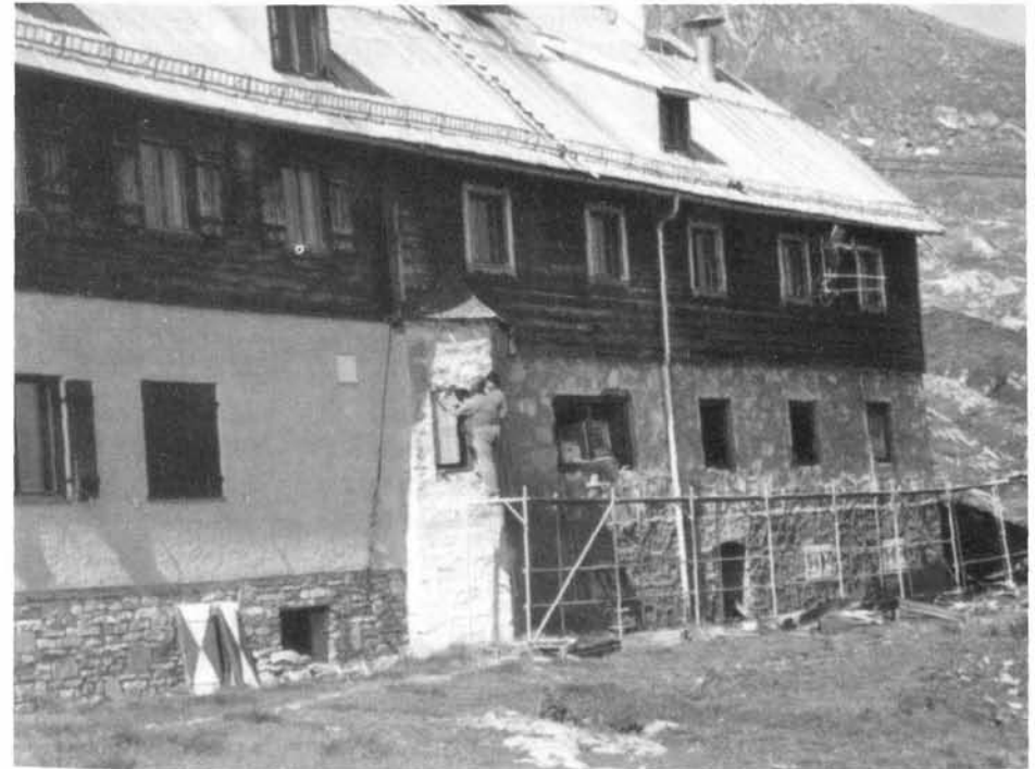
Renovierungsarbeiten mit Erneuerung der Fenster
