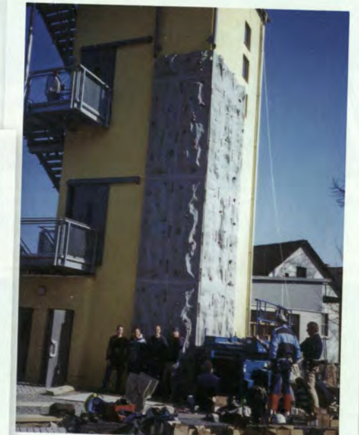
▲ Unsere Kletteranlage nach der Fertigstellung Auf dem Gelände der Landesgartenschau
