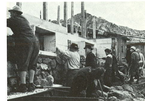
Die Kellerumfassungen werden in Naturstein hochgezogen
