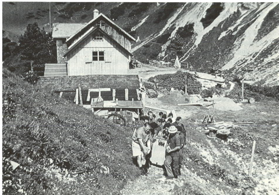
Transport des 6-KV-Trafos für die elektrische Stromversorgung
