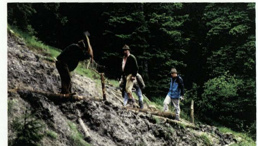
Neubau des Steges über den Sulzerbach
