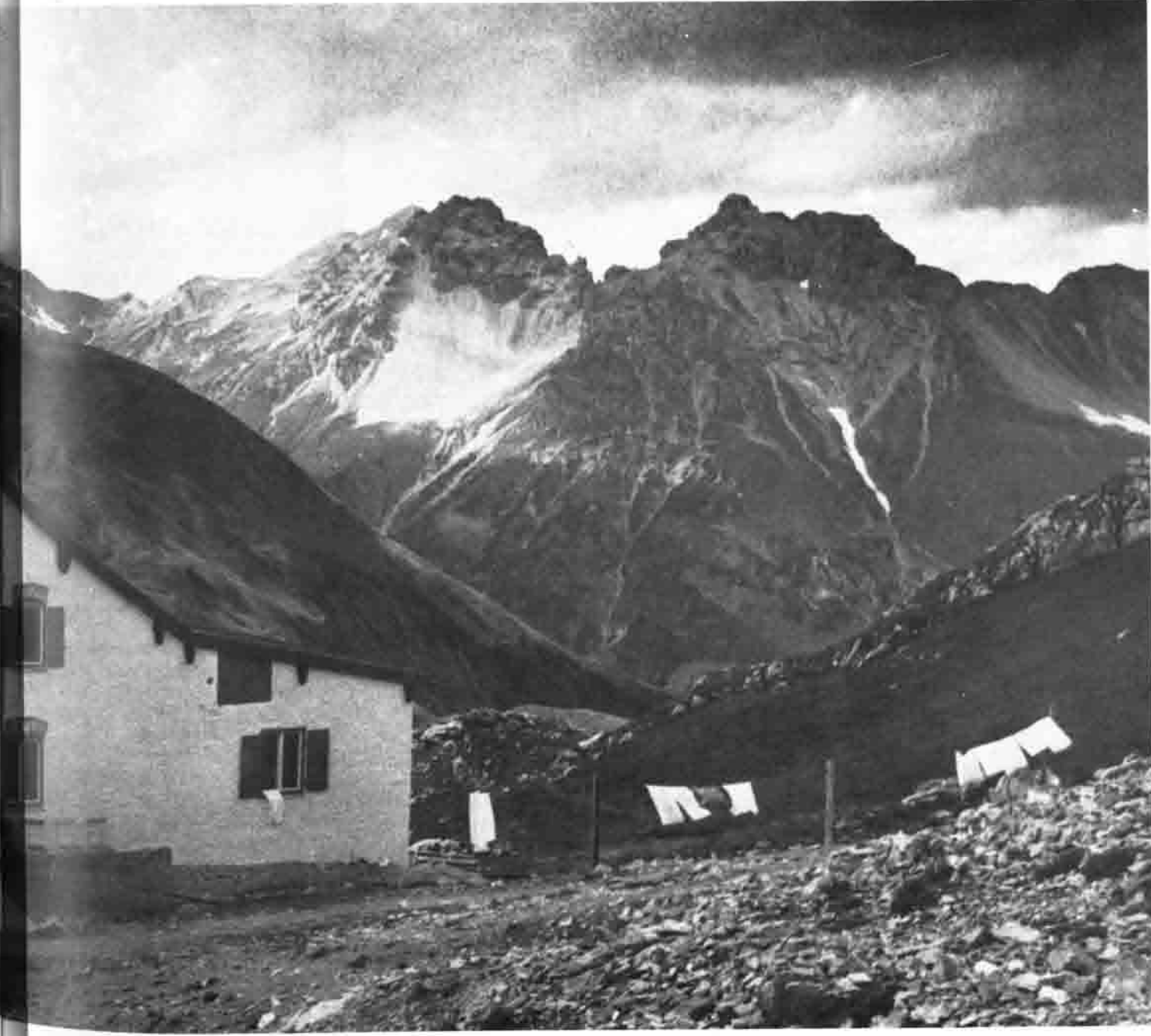
Die Leutkircher Hütte 1974 mit neuem Dach und frisch gestrichener Fassade
