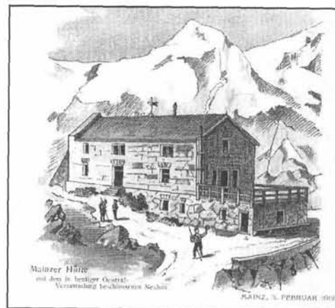
Die von der Sektion Mainz erstmals wieder aufgebaute Hütte mit Anbau (um 1900)
