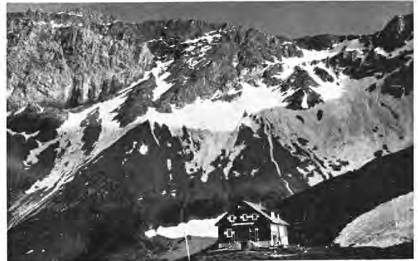
Oberzalim-Hütte nach dem Umbau im Juli 1974
