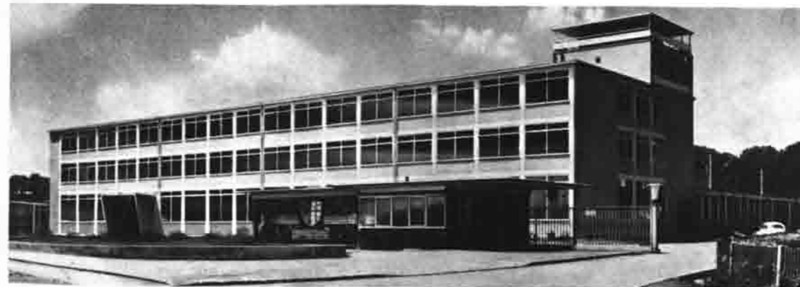
Hauptwerk - Allgäuer Straße 30
