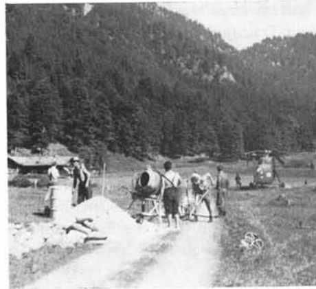
Betonmischen im Nessler Tal
