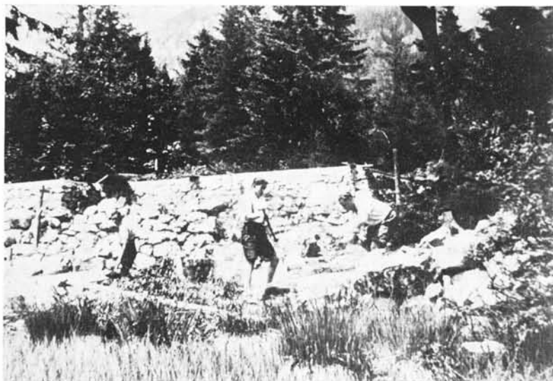
Fundamentbau der Sektionshütte, Sommer 1934
