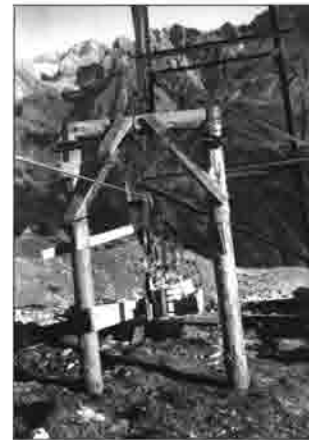
Hilfseilbahn zum Bau der Materialseilbahn 1968
