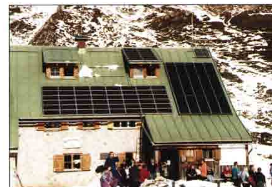
Solaranlage auf dem Dach der Mindelheimer Hütte
