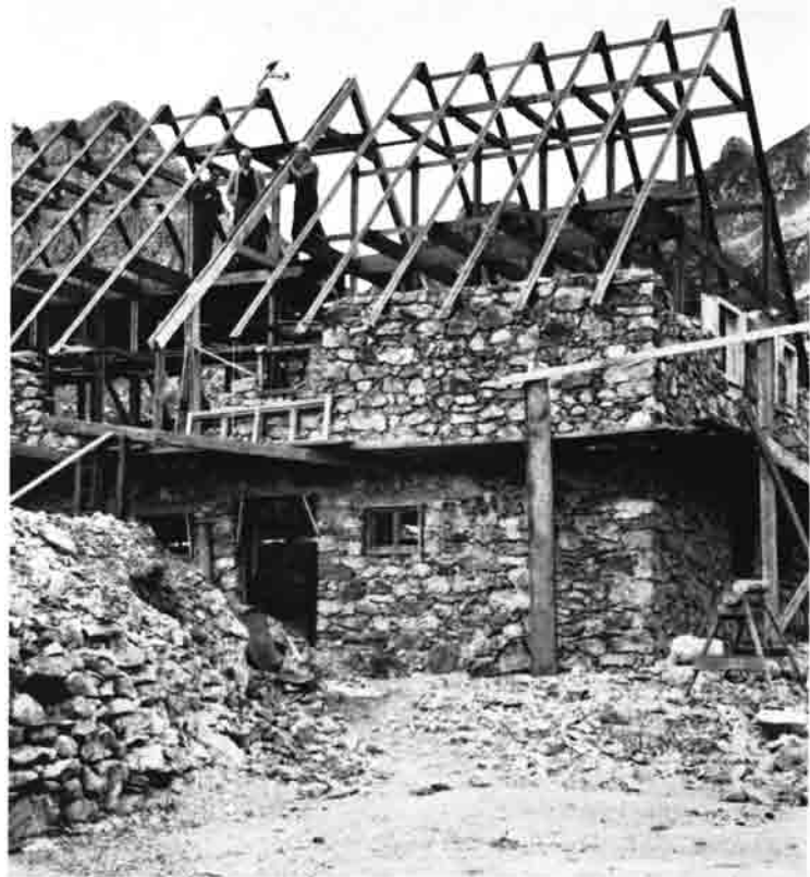
Einbau des 15. vergessenen Binders. Mitte: 1. Vorstand Franz Peter
