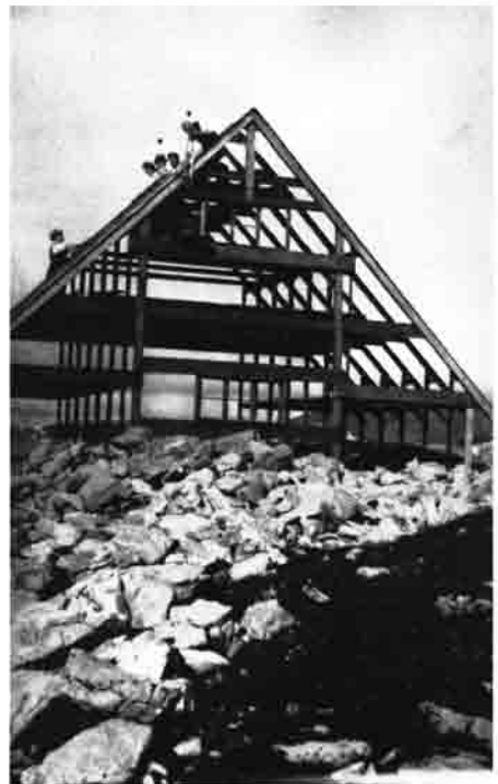
Nothüttenbau — Eiserner Dachstuhl
