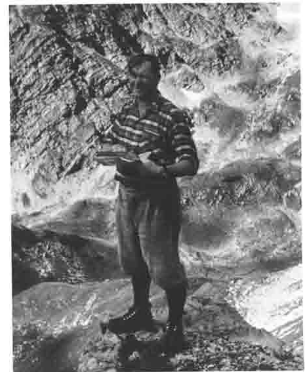
Pius Auerbacher, Hüttenreferent von 1956 bis 1969, leistete großen persönlichen Einsatz (Bau der Weganlage vom Wildental, Bau der neuen Hütte, Verlegung der Wasserleitung und Bau der Materialseilbahn).
