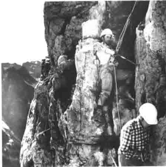
Unter schwierigsten Bedingungen erstellten Arbeiter aus Wart den Mindelheimer Klettersteig.
