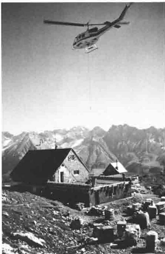
Hüttensatzbau im Herbst 1989 - die Zeit drängte!
