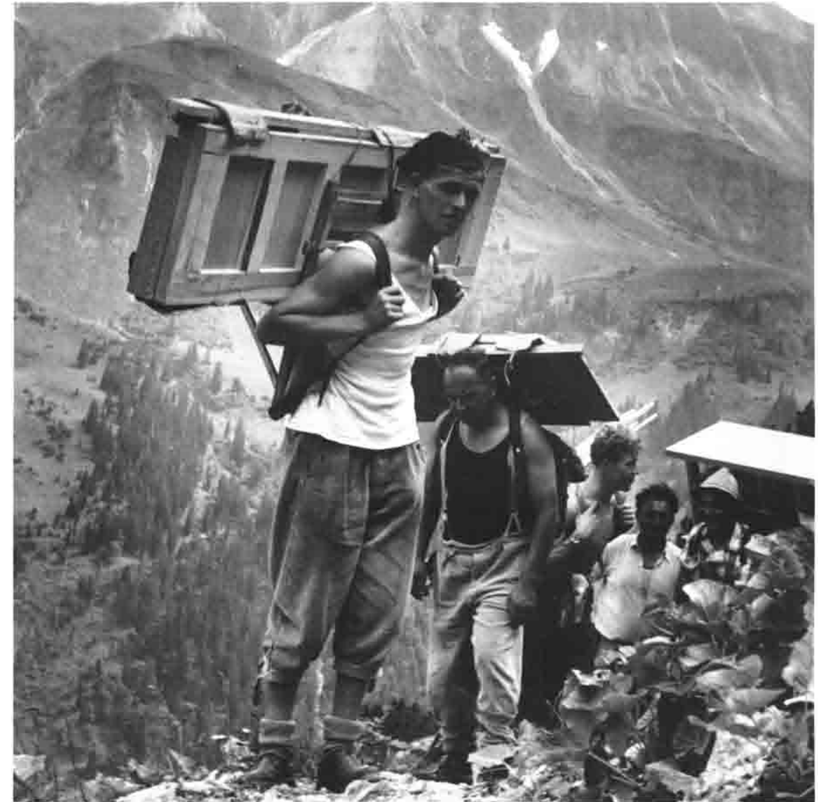
So war es früher: Materialtransport mit eigener Kraft! Ein Küchenschrank muß auf die Hütte.
