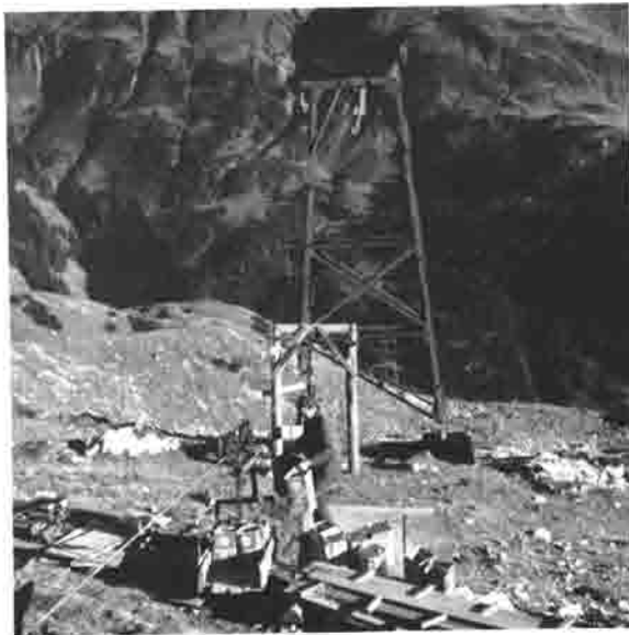
Bau der Materialseilbahn 1968.
