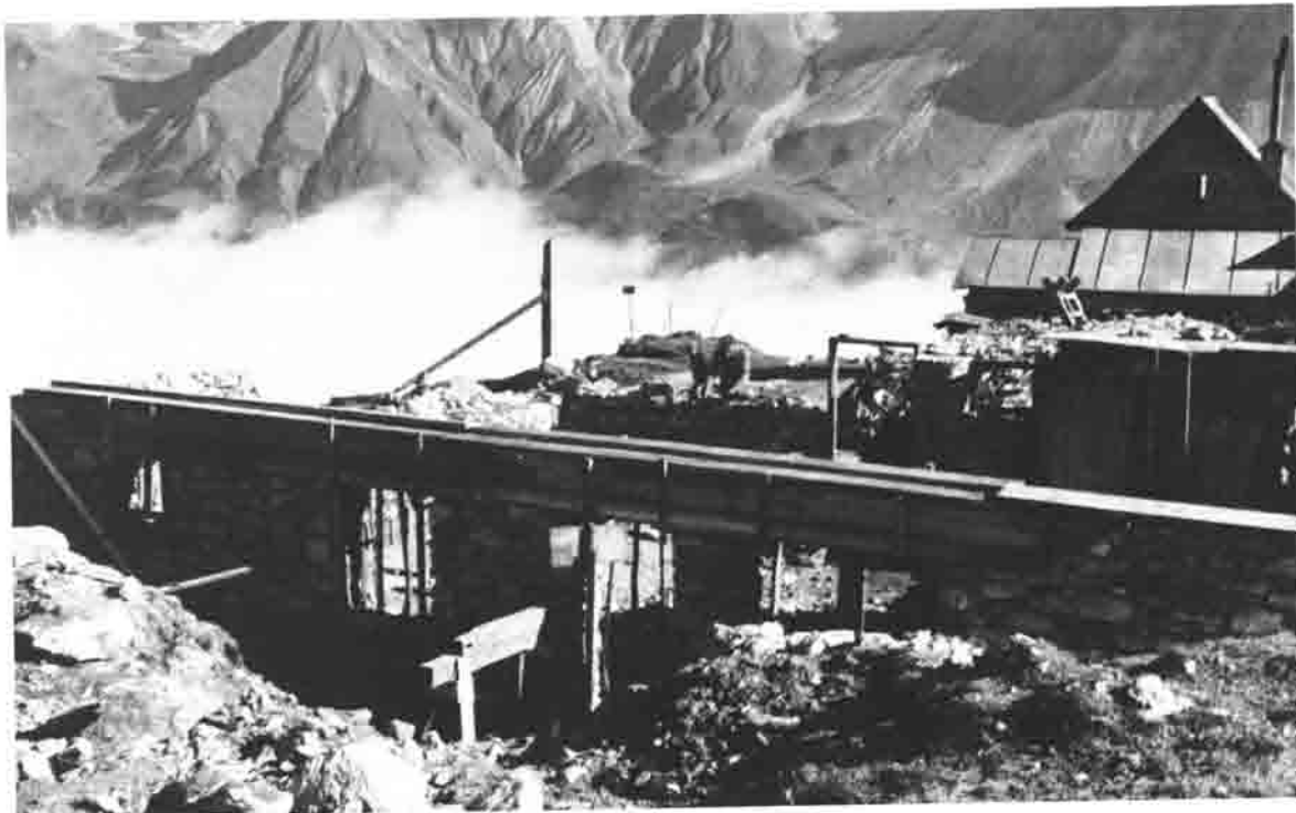
Bau der neuen Hütte 1952 - die Außenwand der Küche nimmt Gestalt an.
