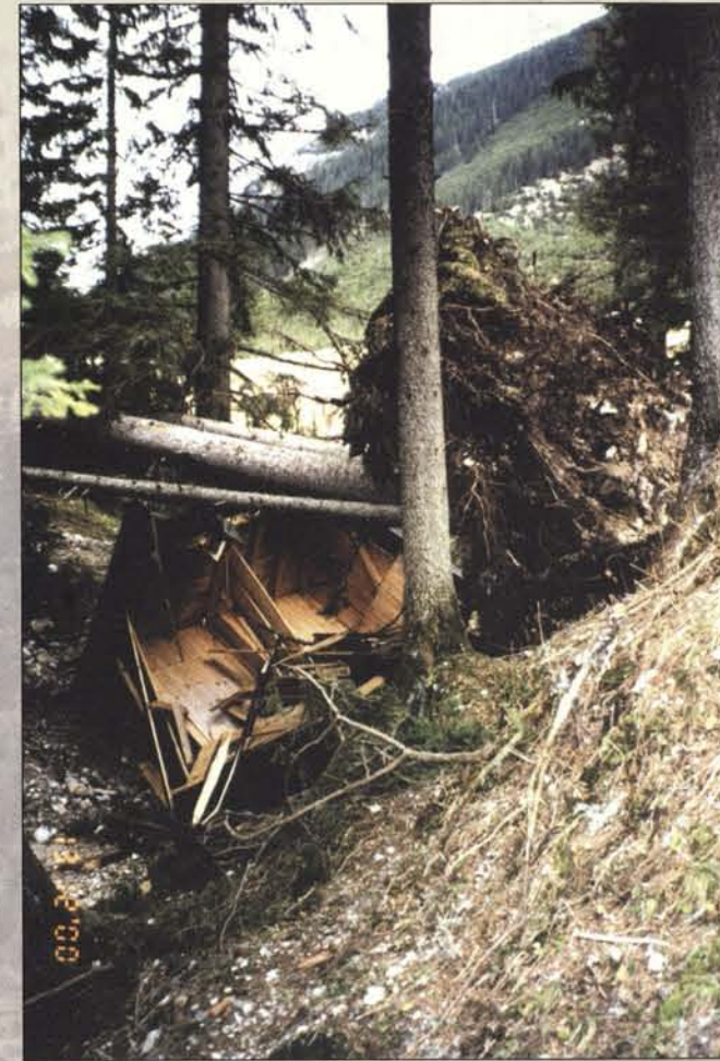
Der Herbststurm hat dann noch das gewisse Örtchen zerstört.
