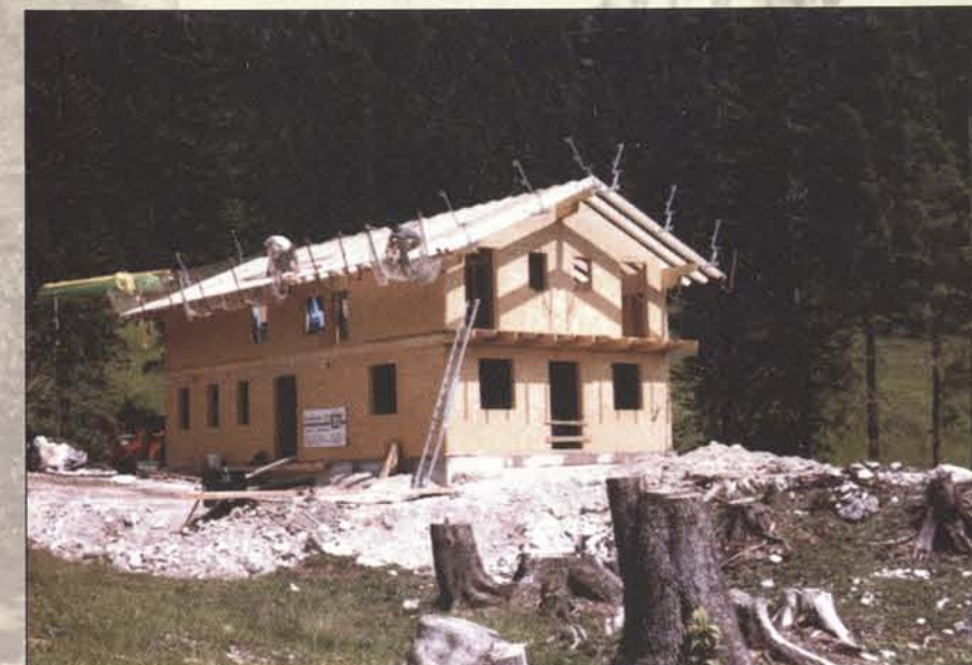
07.07.2003 Das Dach kommt drauf.
