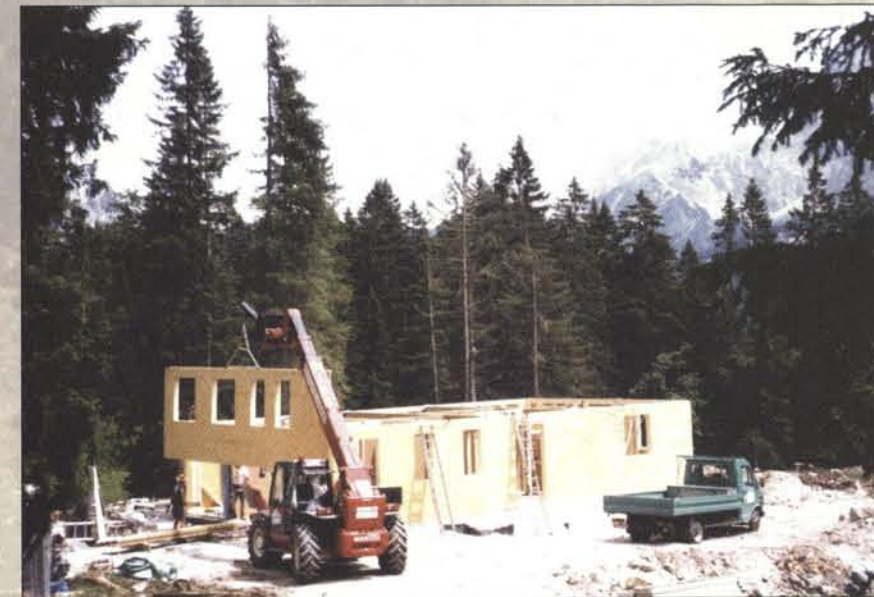
30.06.2003 Der Bau entsteht.
