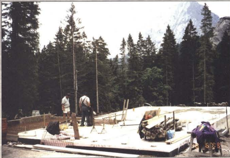
18.06.2003 Die Betonarbeiten (1/3 ist unterkellert) sind fast abgeschlossen.
