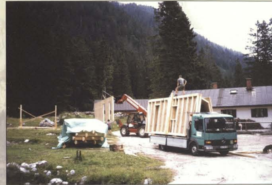
28.06.2003 Die Bauteile werden angeliefert.
