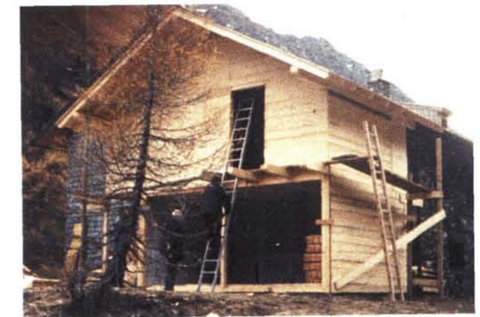
Bilder: links: Einfliegen und Einsetzen von Sammelbehältern und Fettabscheider. rechts: Haus für Reaktorbehälter und Winterraum (Anbau am Anbau)
