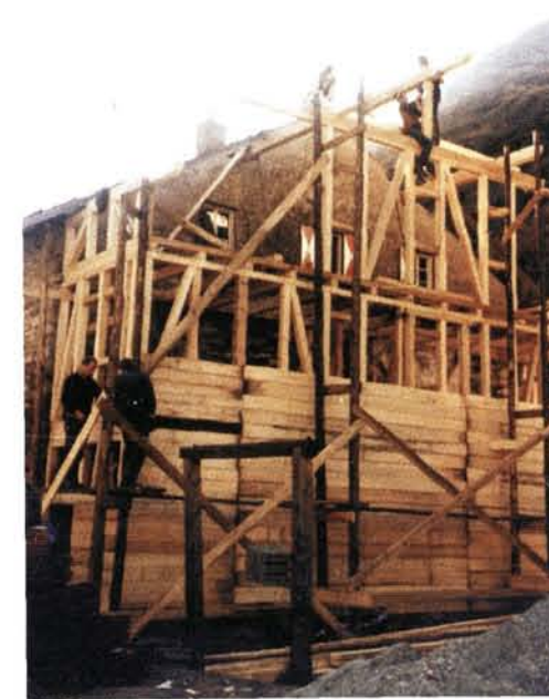
Das Haus wird um den Anbau verlängert.
