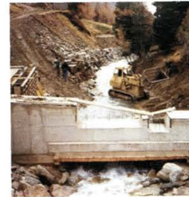
Wasserfassung im Bau
