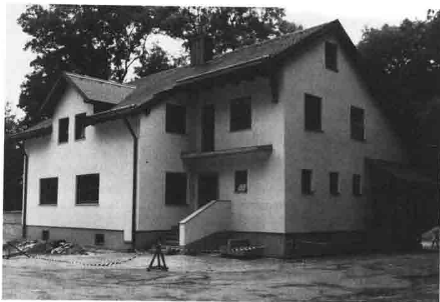
Das neue Gebäude kurz vor der Fertigstellung
