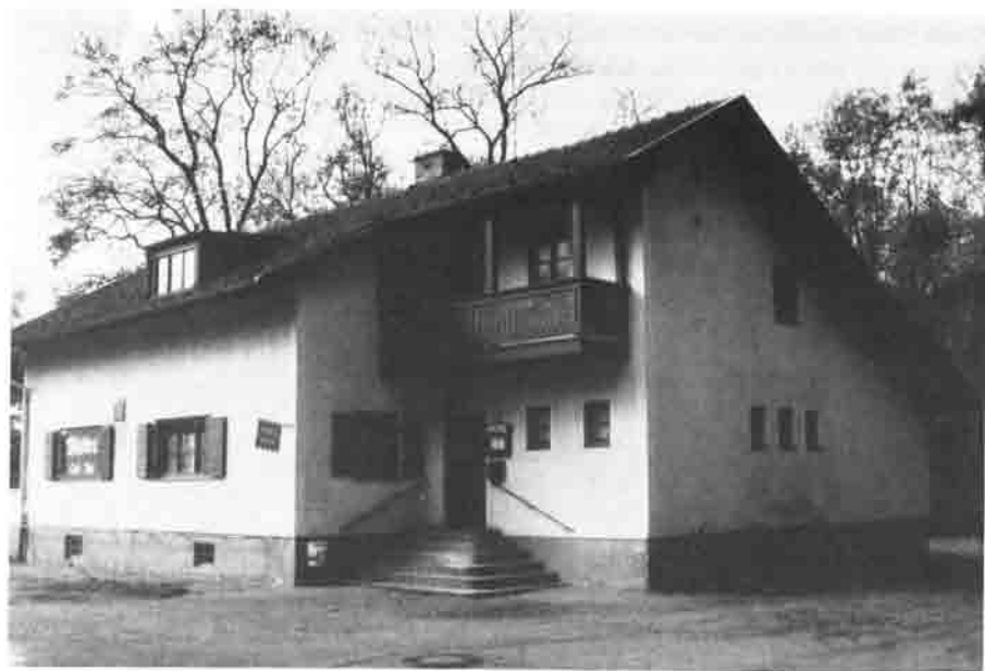
Altes Bistro-Gebäude kurz vor dem Abbruch
