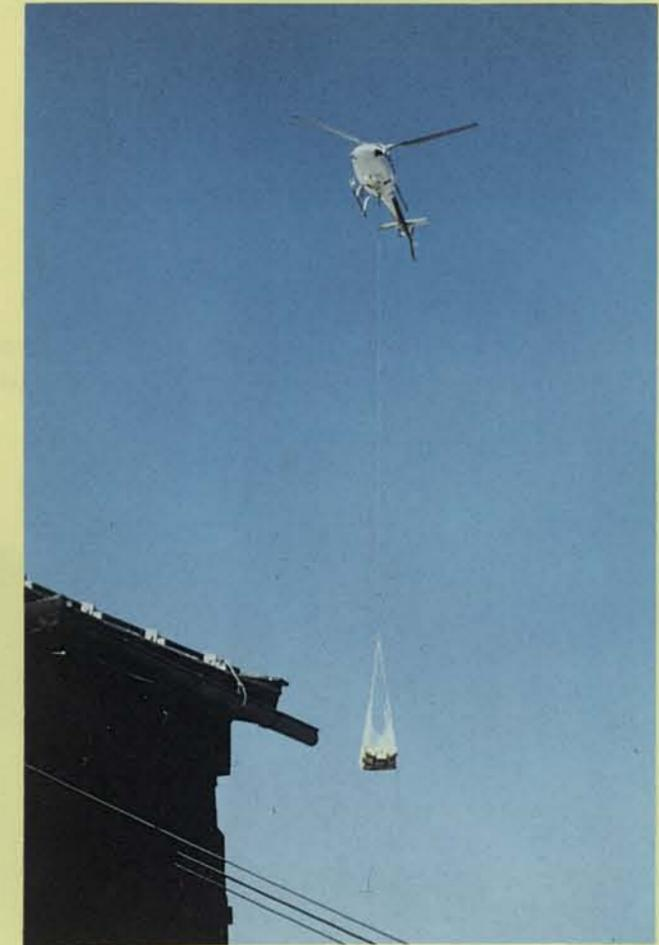
Der Hubschrauber mit einer Ladung Dachschindeln, verstaute in einem Transportnetz, im Anflug auf die Baustelle.
