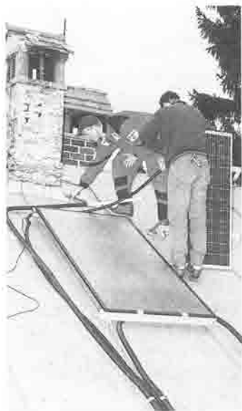
Montage der Solaranlage auf der Gumpertsbergerhütte
