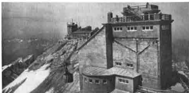
Abb.: „Zugspitzmittelgipfel“ vor und nach dem Bau der Bergstation der Bayr. Zugspitzbahn
