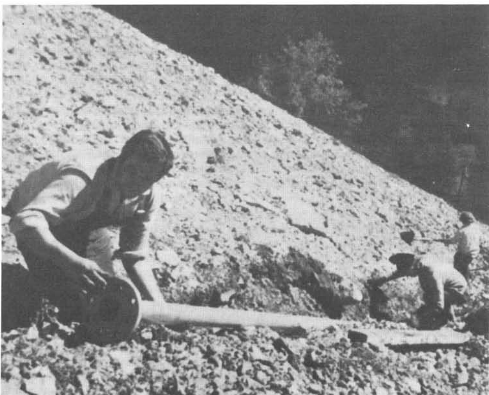
Verlegen der Rohre für die neue Wasserleitung
