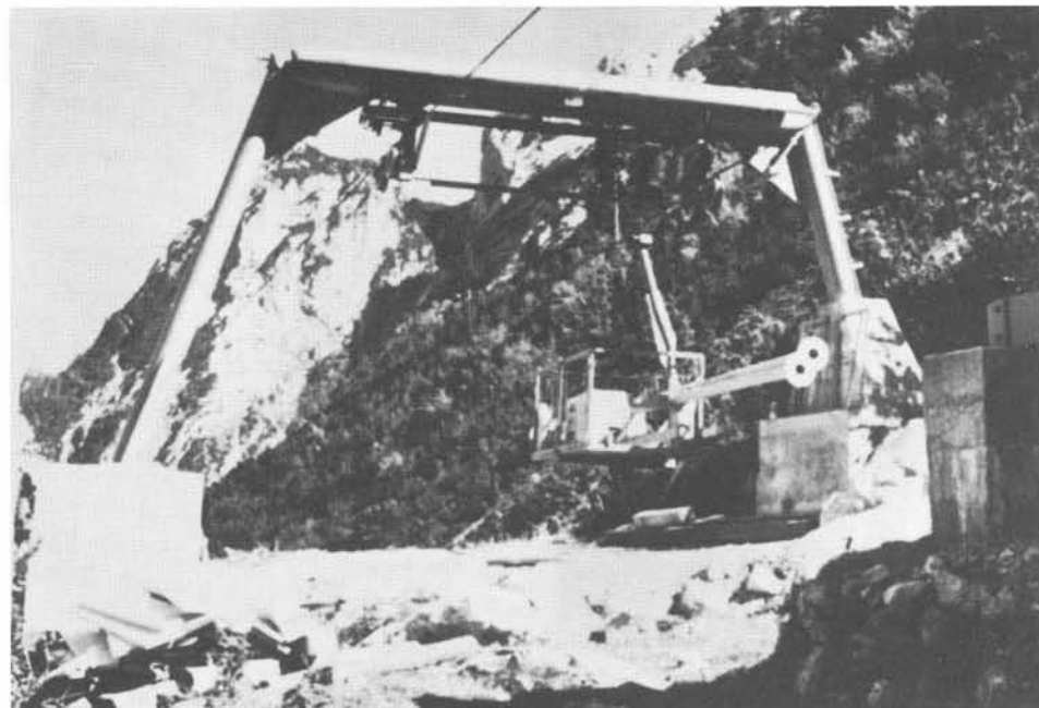
Transport der Wasserleitungsrohre, Ankunft auf der Bergstation
