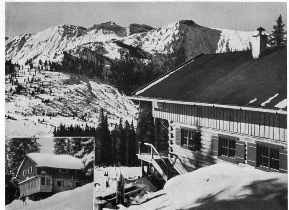
Guffertthütte gegen Guffert und Schneidjoch
