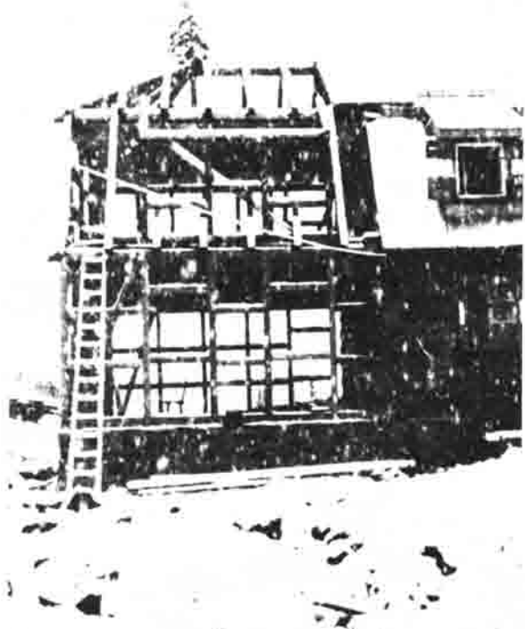
Sommer 1970 – Der neue Anbau ist gerichtet
