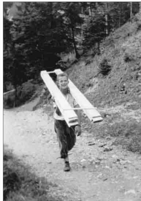
Material für den Bau der Holz- und Gerätehütte konnte nicht immer auf Mulis verladen werden.
