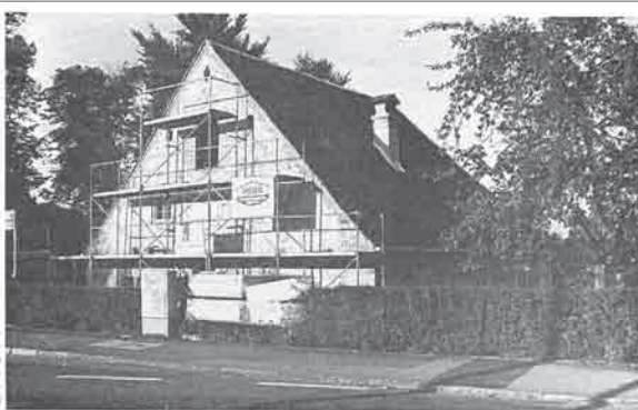
Die 1800 erbaute „Heuwaage“ wird derzeit einer umfangreichen Totalsanierung unterzogen. Foto: her
