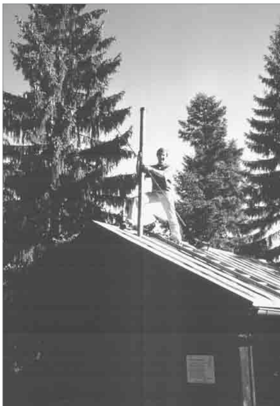
Montage der Solaranlage über der Holzhütte. Mit ihr konnte die Energieversorgung optimiert werden.
