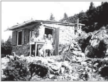
Im Winter 1932/33 stand bereits die kleine aber wetterfeste Bauhütte.
