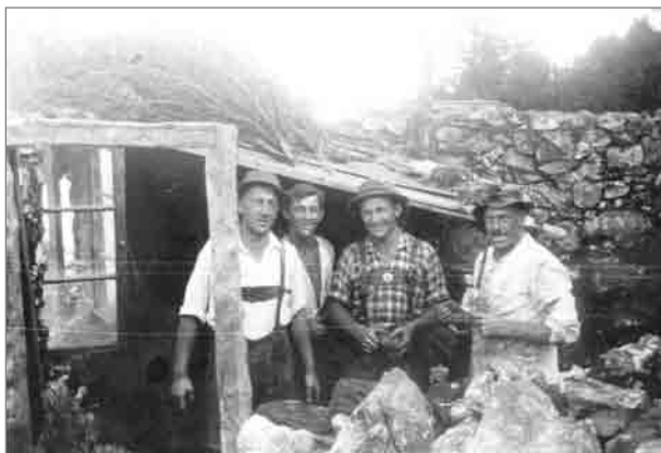
In der kleinen Bauhütte werden Pläne geschmiedet, Materialien gelagert und bearbeitet.
