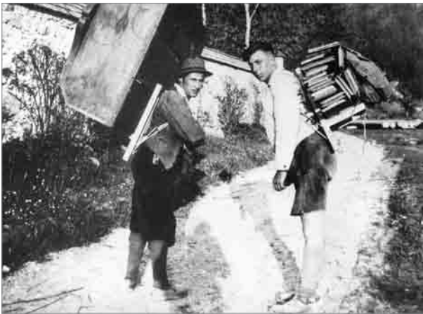
Ausrüstung, Baumaterial und Verpflegung mussten in der Anfangszeit mit Kraxen zur Hütte hinaufgeschafft werden.
