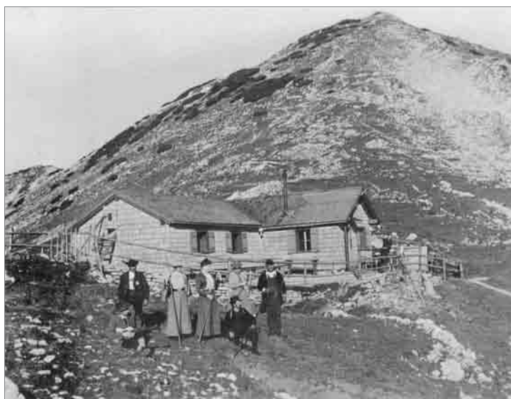
(5) Die Krottenkopfhütte, erweitert 1894 nach den neuen Konzepten des DAV.
