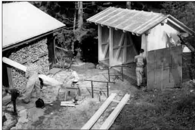
Bau der Holzlege
