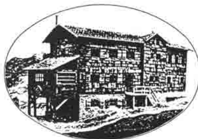
Ost- u. Nordseite.
