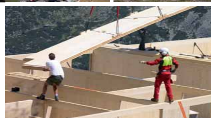
Bauleiter Ernst Pfeifer und Architekt Hermann Kaufmann (rechtes Bild) beobachten den Fortgang der Bauarbeiten.
