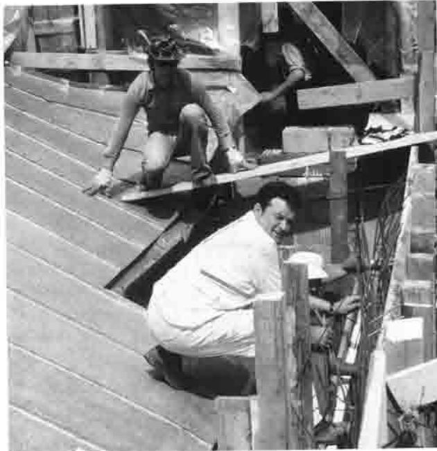
Die Betonbauer mit H. Mailänder. Links das alte Hüttdach
