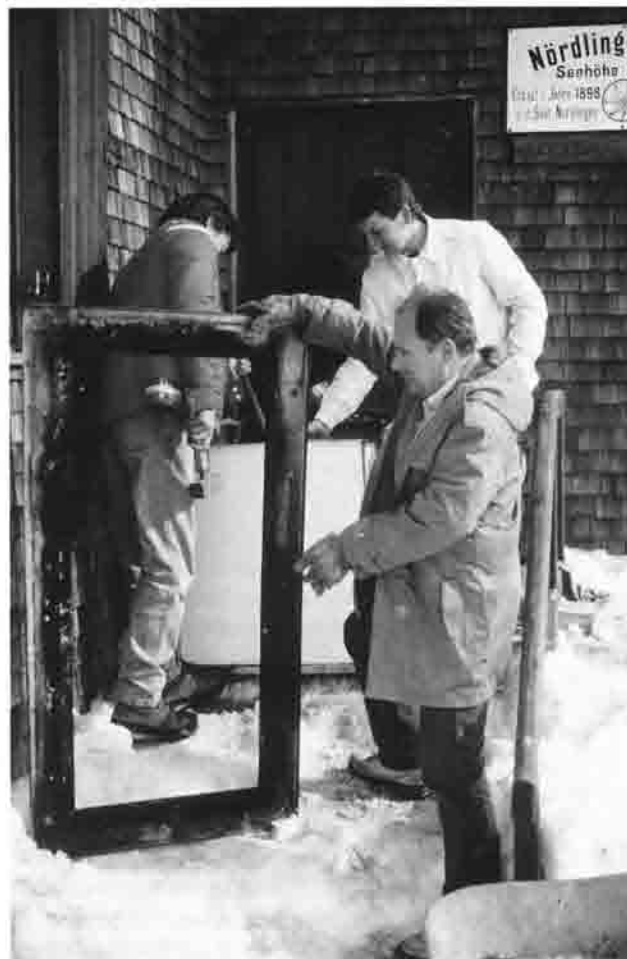
Sehr schwierig gestaltete sich der Herdaus- und -einbau
