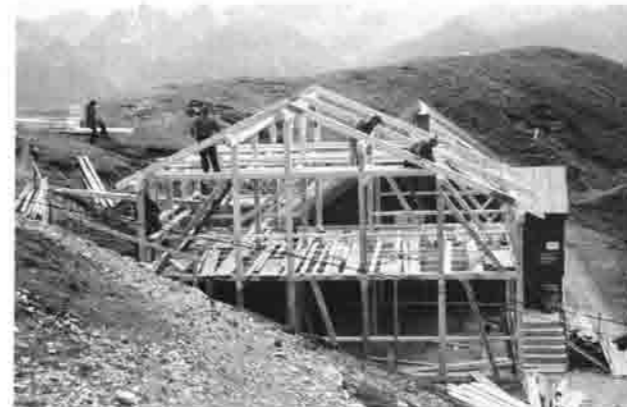
Der Neubau wird aufgerichtet
