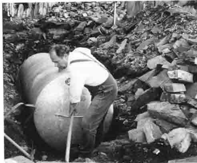
Schwierigste Bodenverhältnisse erforderten höchste Leistung; hier Einbau eines Wassertanks
