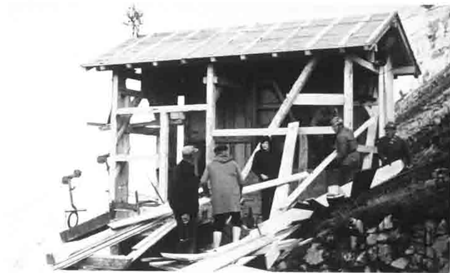
Der Bau der neuen Bergstation
