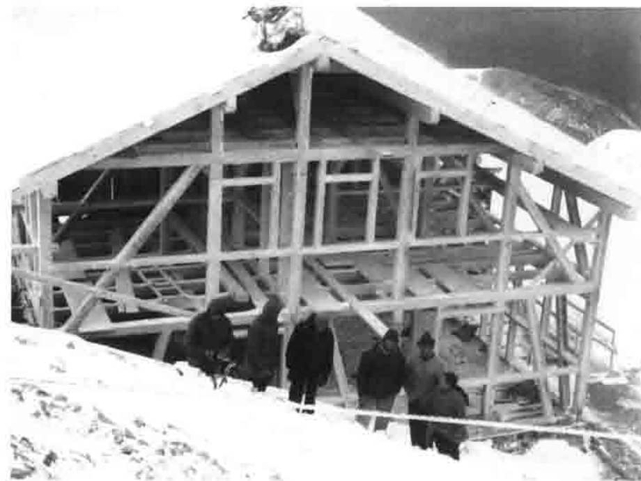
Das Fachwerk der Hütte ist errichtet
