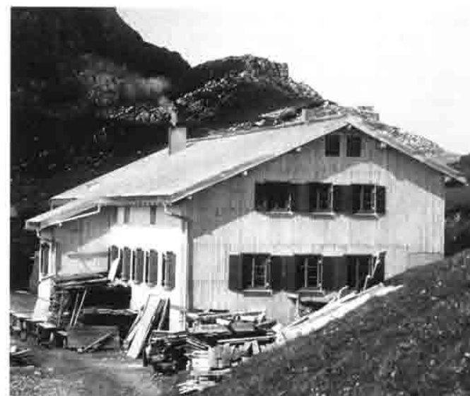
Nun fehlt nur noch die Verschindelung
