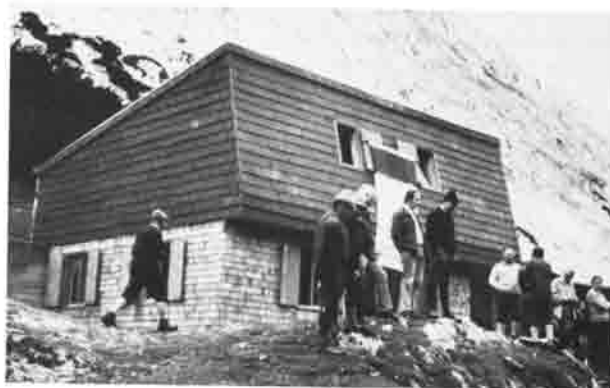
Der Neubau wird beschindelt.
