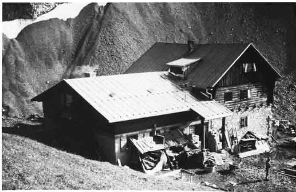
Die Anhalter Hütte mit neuem Anbau (oben).
