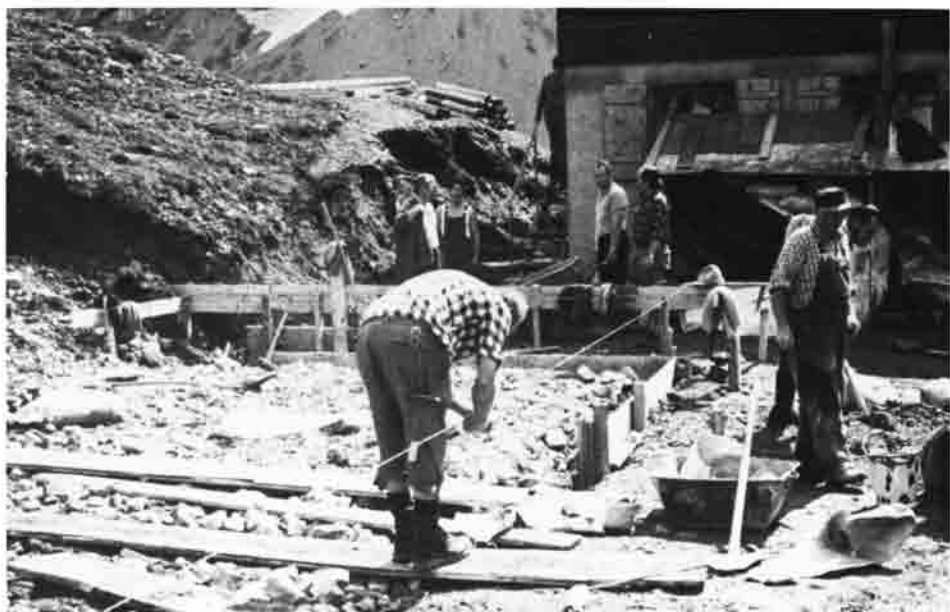
Bau des Nebengebäudes (unten).
