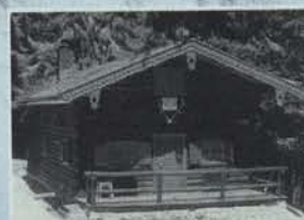
1938/39: Bau der Blankensteinhütte
