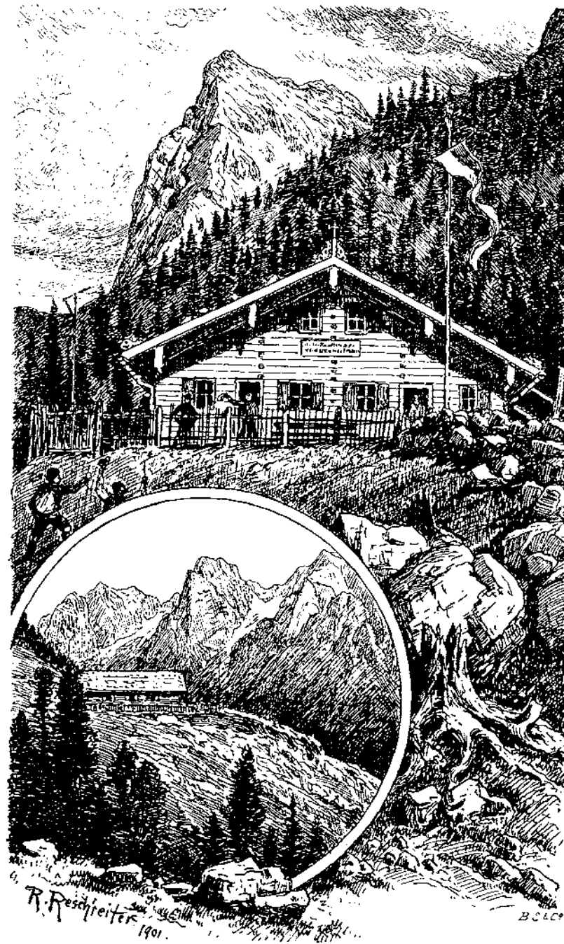
Vorderkaiserfelden-Hütte nach dem ersten Umbau und 3. J. des Erwerbes.
