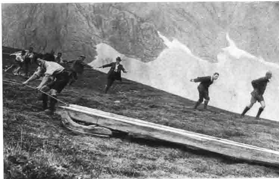
Arbeitsdienst beim Bau der Falkenhütte (Balken-Sprengen)
