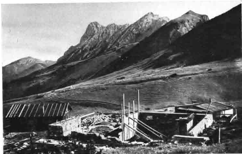
Bauplatz der Falkenhütte mit Falkenstock
