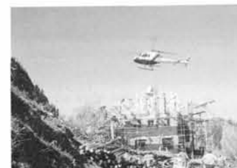
Dachbau mit dem Hubschrauber
