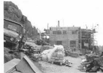
Das Dach wird abgerissen
