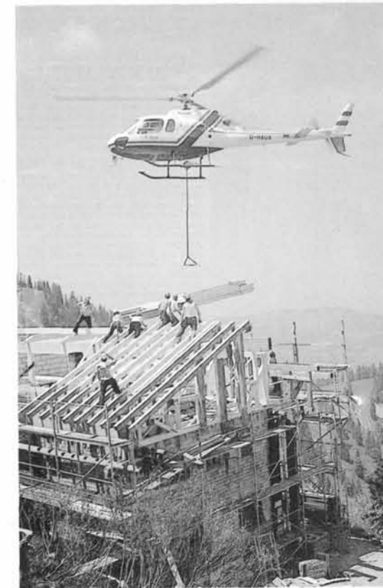
Neubau des Dachgeschosses am »Staufner Haus«
