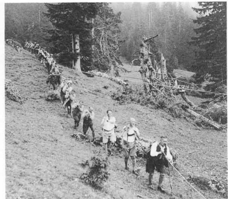
Bau der Seilbahn
