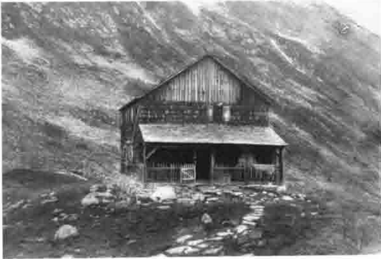
Der im Frühjahr 1909 durch Lawinendruck zerstörte Vorbau nach der Wiederherstellung im gleichen Jahre.
