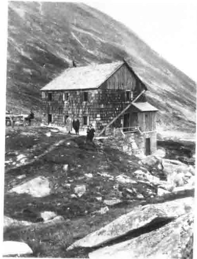
Die Osnabrücker Hütte im September 1926.
