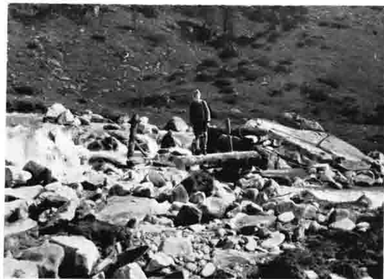
Der 1937 zerstörte Reckenbichlstieg über den Kleinleimbach.
