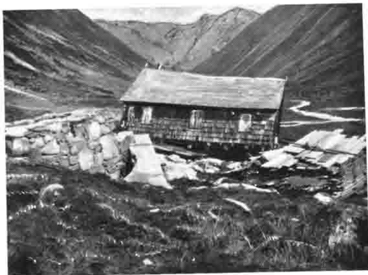
Die Februar 1929 durch Lawinendruck zerstörte Osnabrücker Hütte.
