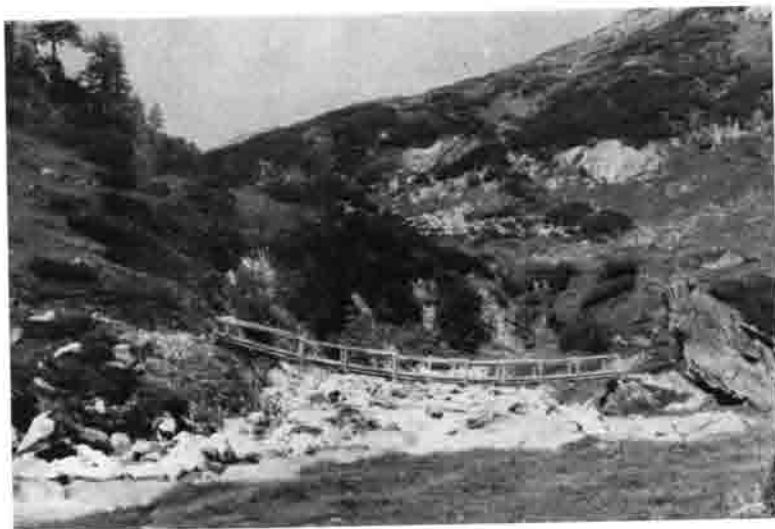
Der neue Reckenbichlsteg über den Kleinfendbach, 50 Meter oberhalb.
