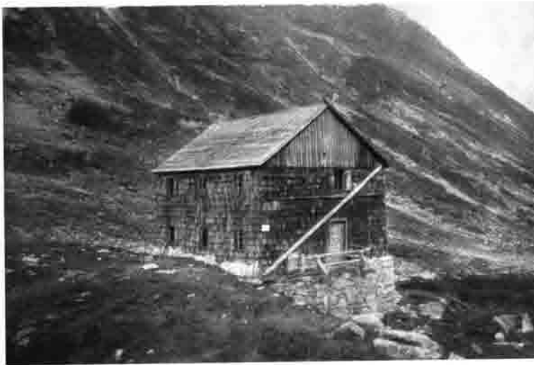
Die Osnabrücker Hütte nach ihrer Talabverschiebung durch Lawinendruck März 1923, unterbaut und verstärkt.
