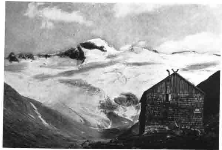
Der Standplatz der Osnabrücker Hütte von 1899 bis 1993.
