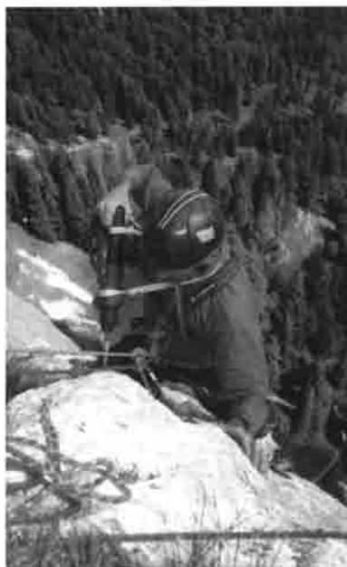
Beim Routensanieren in der Geißelstein Ostwand
