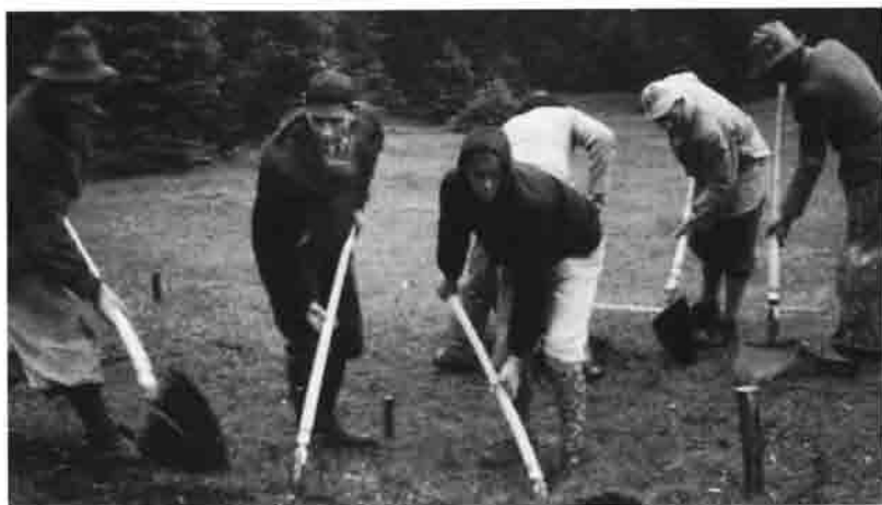
1. Spatenstich zur Wankkapelle
