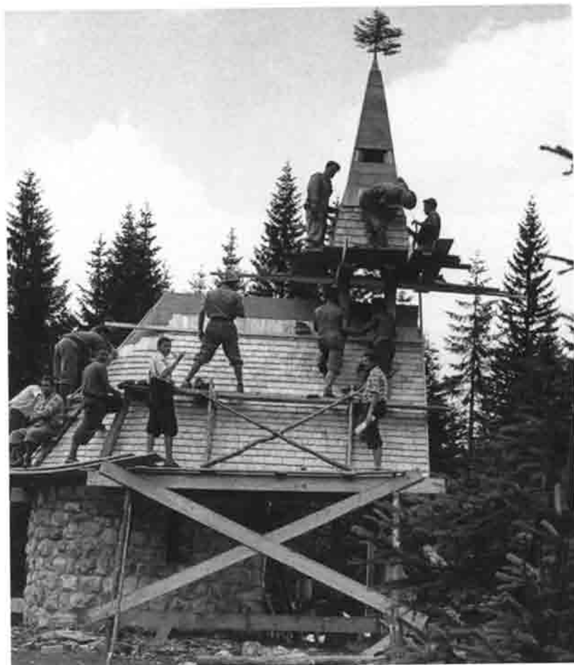
Dachdeckung und Hebauf
