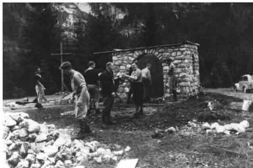
Kapellenraum im Rohbau
