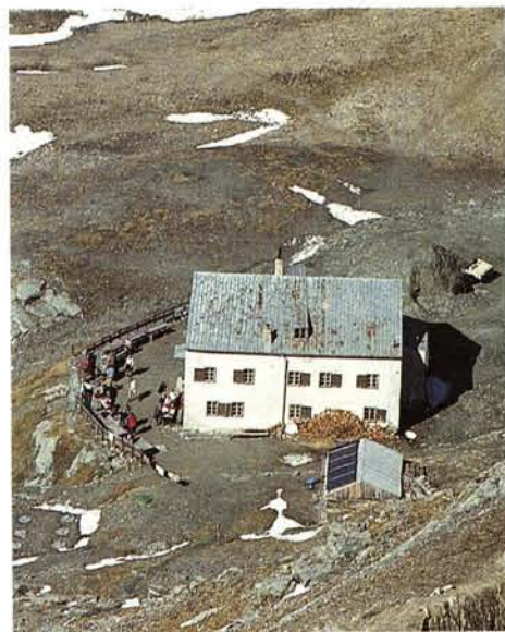
Sonnenkollektoren auf dem Dach des Waschhauses.
