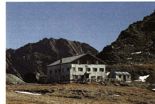
Bauzustand seit 1933 mit neuem Nebengebäude (Waschhaus und Mulistall), die Terrasse wurde 1980 angelegt.
