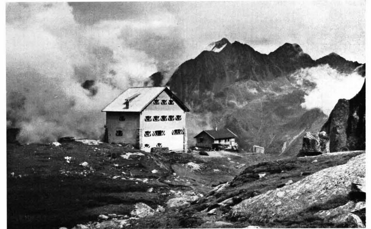
Neue Regensburger Hütte vor der Erweiterung
